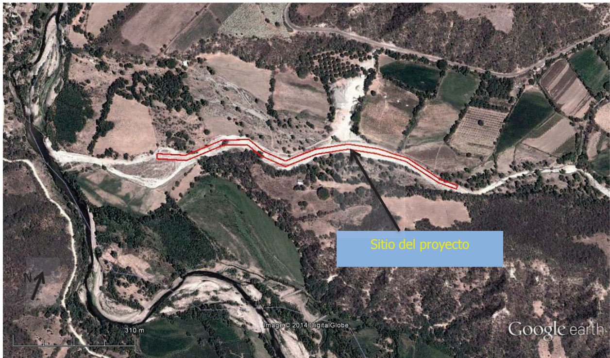
Montaje donde se muestra el material expuesto a lo largo del proyecto (en época de estiaje)
