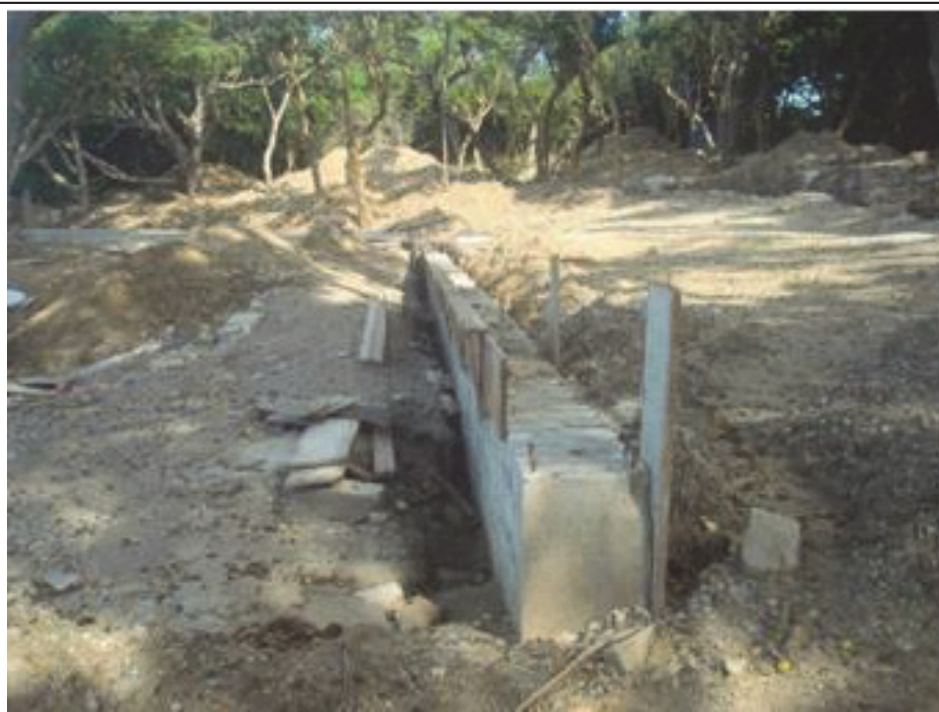
Muro de contención tres, pedacería de madera cortada utilizada durante la etapa de construcción.
