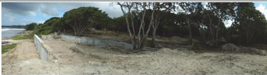
Panorámica del proyecto en su estado actual, se muestran las obras construidas parcialmente, actuadas por la PROFEPA.
