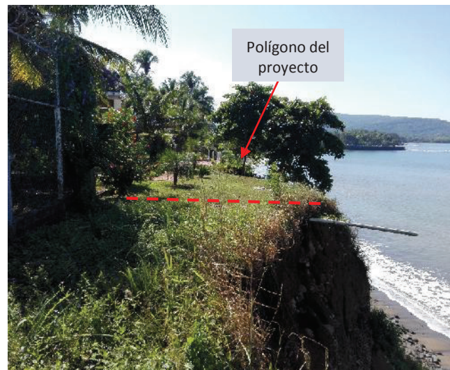
Figura II.3 Condiciones del terreno a la orilla del desfiladero.
