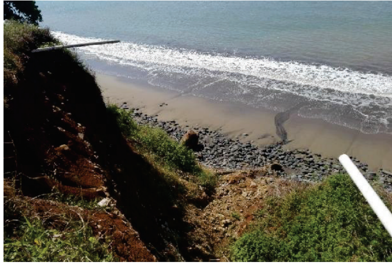
Figura II.5 Área de construcción del muro de contención
