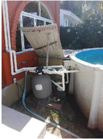
Figura II.11 Conexión de tuberías alberca
