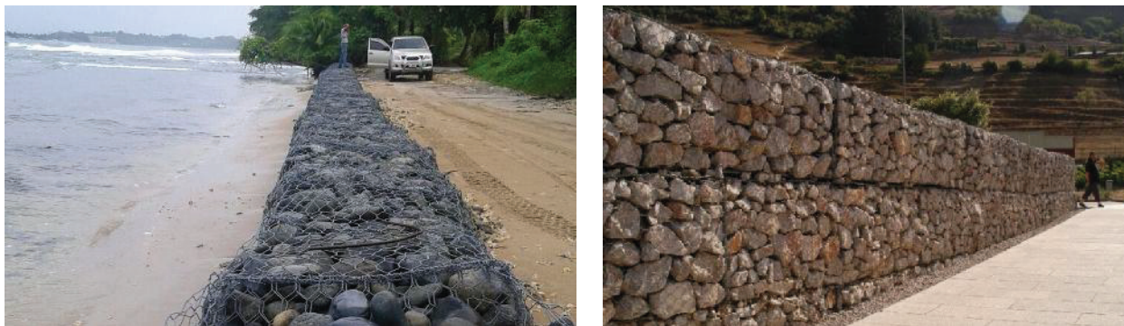
Ilustración VI.3 Ejemplificación del muro de gaviones a instalarse
