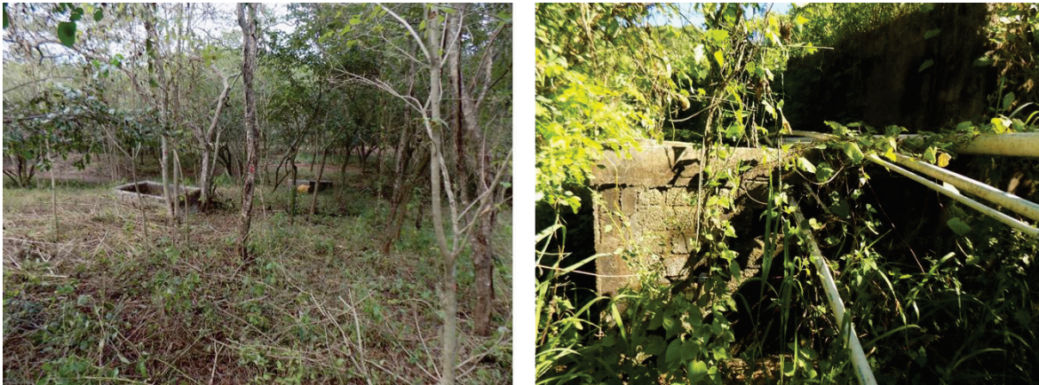
FIGURA II. 4 VISTA LATERAL DE LA BODEGA EN RUINAS Y DE LA CASETA DE SEGURIDAD
