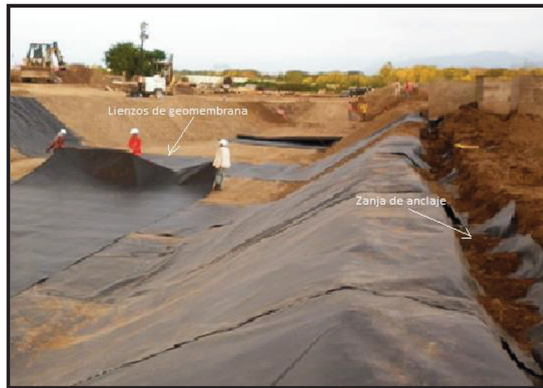
Fig. II.5 ejemplifica el proceso de construcción de las zanjas de anclaje y colocación de geomembrana.
