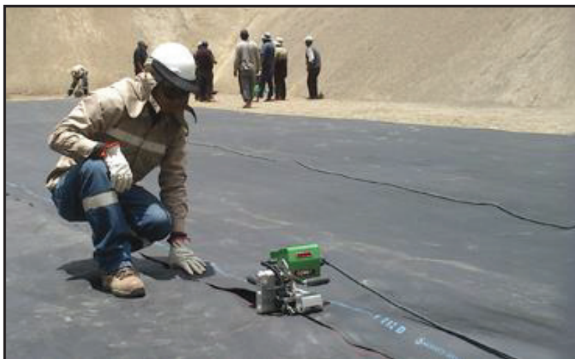
Fig. II.6 ejemplifica el proceso de termofusión de la geomembrana para impermeabilizar el lago.
