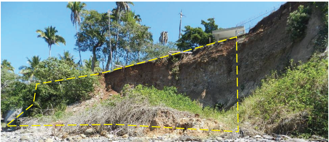
Figura II.5 Área de construcción del muro de contención
