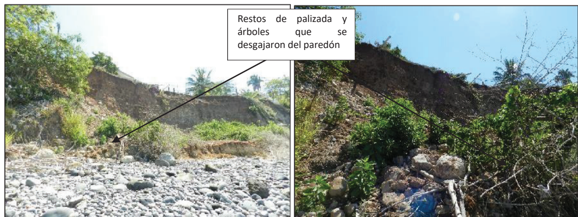
Figura VII.1 Árboles caídos por efectos de erosión del suelo
