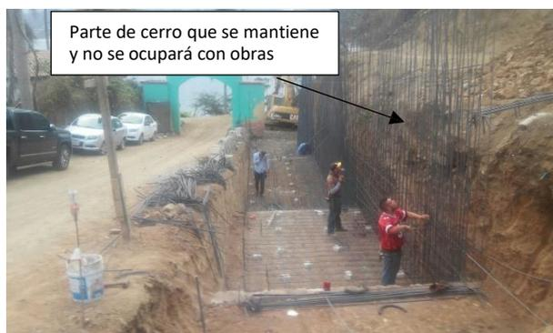
**Foto III.1** Muestra obras de preparación del sitio con la cimentación y excavación
