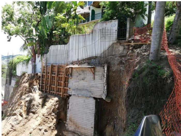
*Foto II.2 Condiciones de riesgo de derrumbe del terreno aledaño por las actividades de construcción.*
