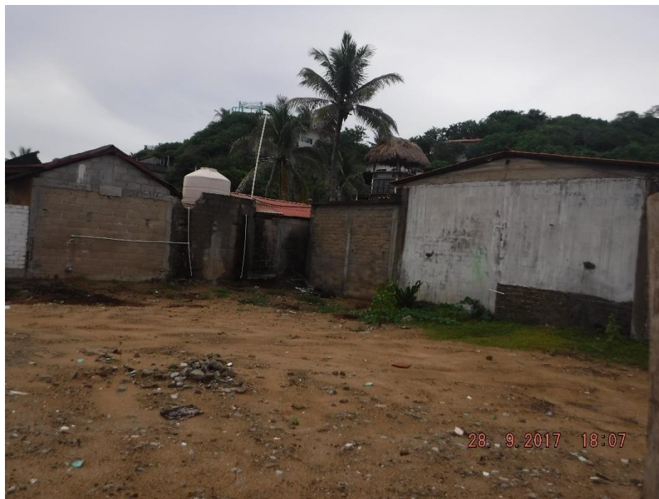
Figura VIII.4 Vista panorámica de la zona de posición Norte-Sur.
