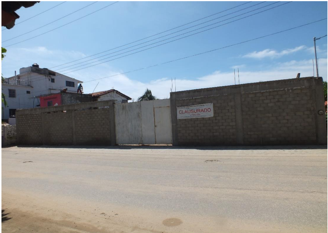
Fotografía 6. Lado Norte de Predio y acceso por carretera.
