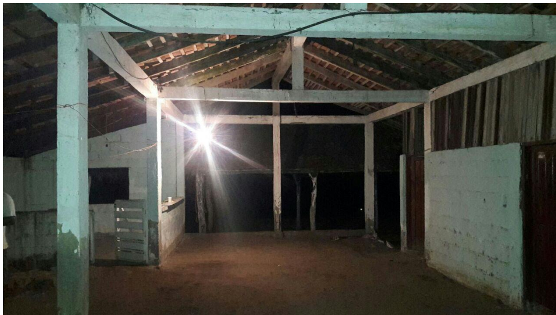
Fotografía 1. Construcción anterior al proyecto en el predio.
