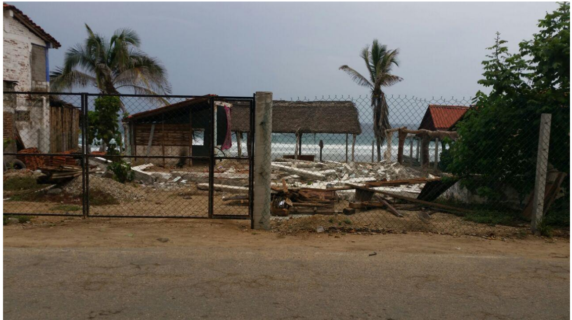
Fotografía 3. Demolición de obra previa al proyecto.
