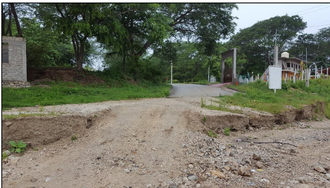
Fig. IV. 14. Camino principal que atraviesa el río
