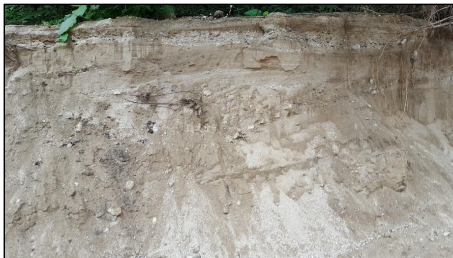
Fig. IV.9. Erosión en la margen de una curva
