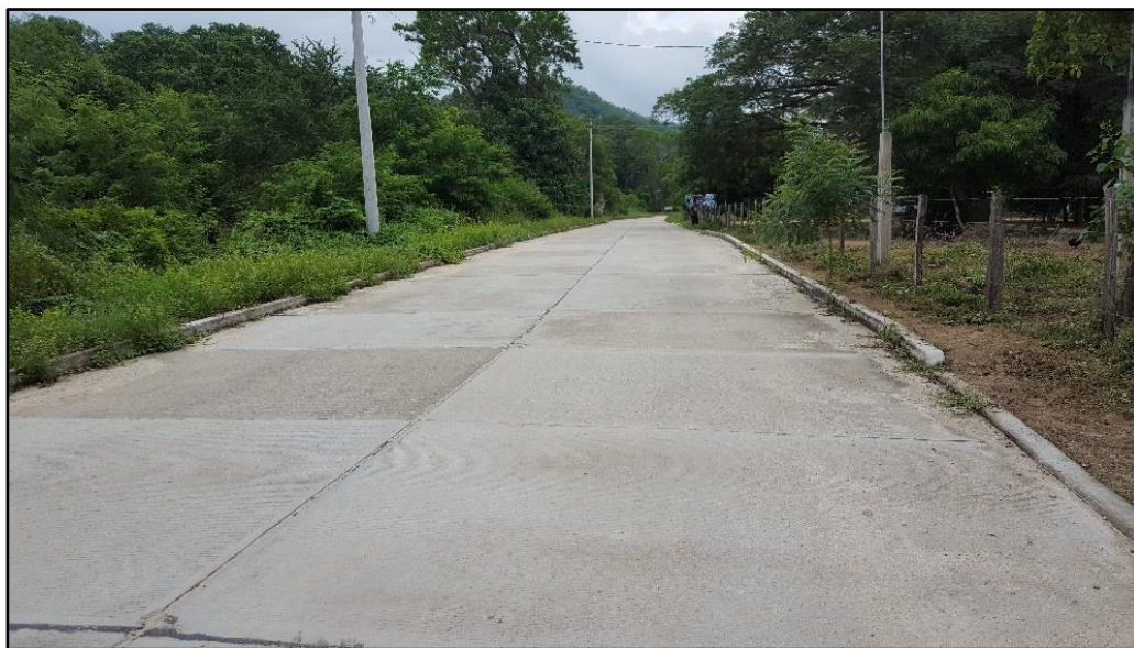
Fig. II.1. Acceso pavimentado hacia la localidad
