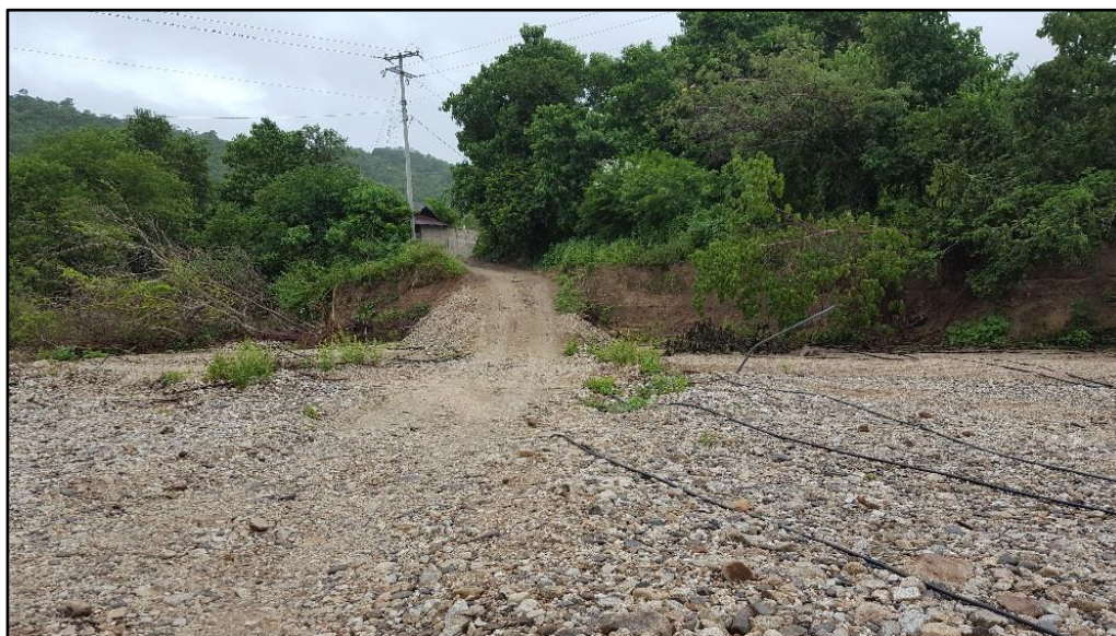
Fig. II.2. Calle que atraviesa el lecho del río y que comunican asentamientos humanos con la calle principal
