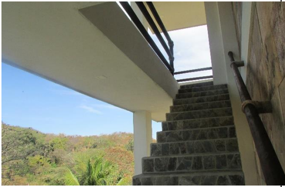
Escaleras que conducen a la azotea del edificio
