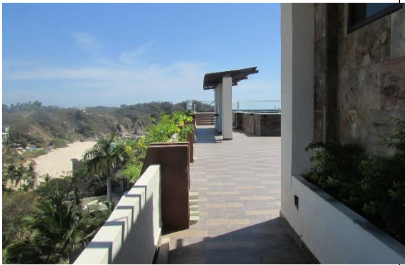
Jardineras en el techo del edificio
