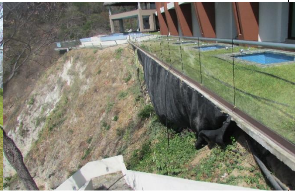
Losa de concreto tipo volado
