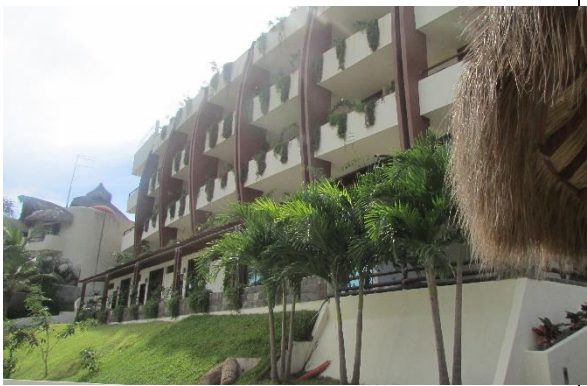
Edificio principal vista frontal se observan los pasillos
