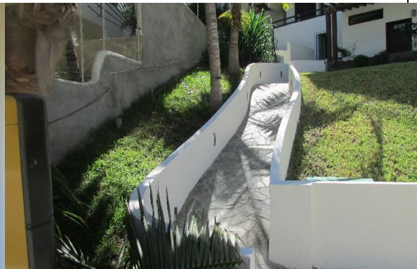
Rampa de acceso
