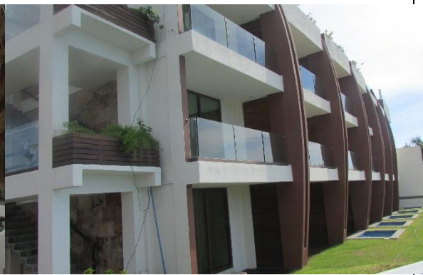
Edificio principal vista posterior se observan las terrazas
