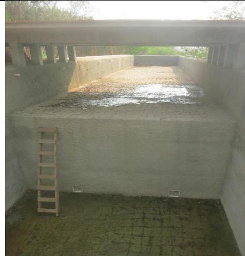
**Figura 32.** Fosa de clavados de la alberca, arriba se sostiene el asoleadero con las bases de armado de concreto.
