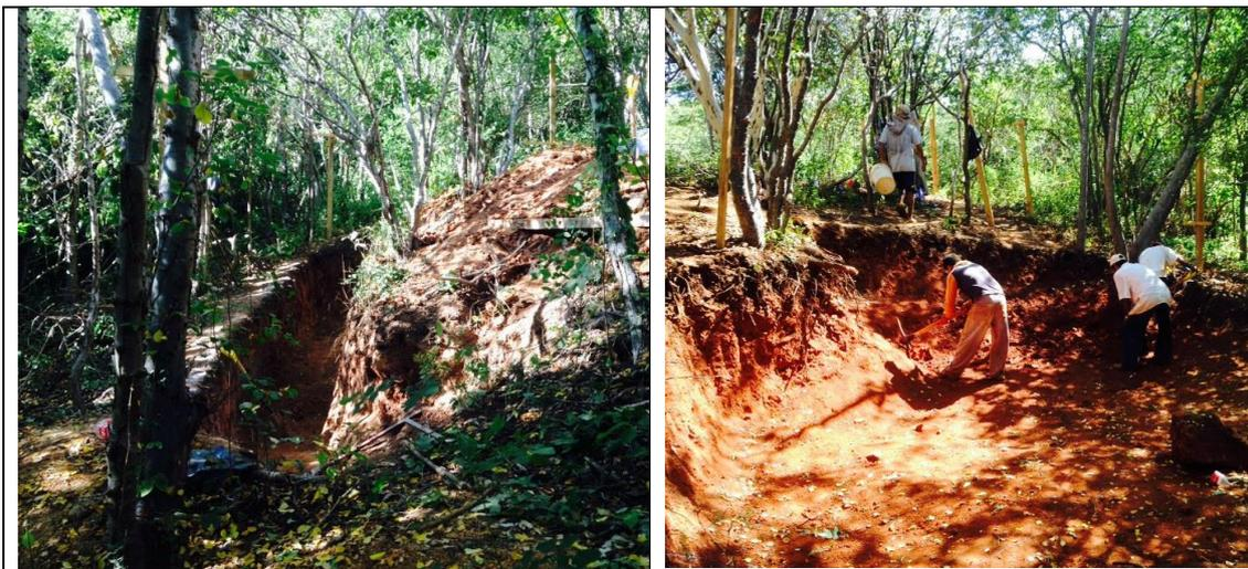
**Figura 47.** Preparación del sitio, se realizó en forma manual, utilizando palas, picos, cubetas y carretillas para extraer los materiales pétreos.
