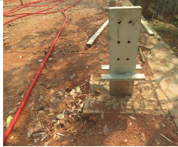
**Figura 28.** Bases de metal donde se anclarán los postes que sostendrán a la palapa.
