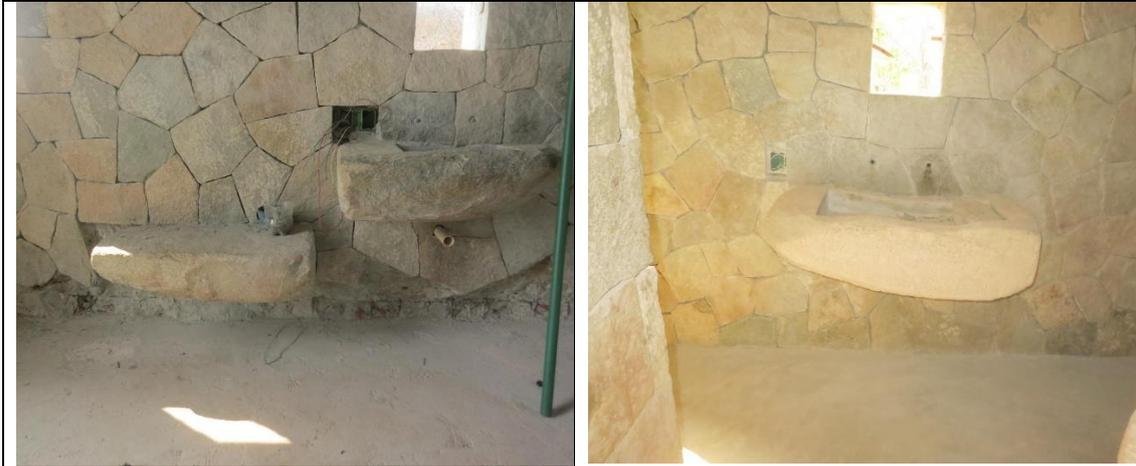
**Figura 39.** Diseño de los lavamanos, tipo rústicos labrados en piedra blanca.
