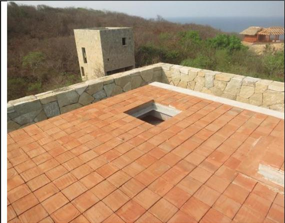
**Figura 23.** Azotea de la Torre 1, entre las vigas de madera y las tejas de barro se encuentra los depósitos de agua, en la foto se observa la tapa de la cisterna.
