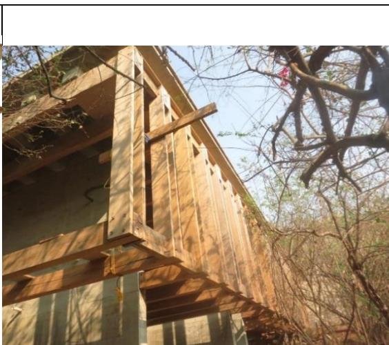
**Figura 34.** Estructura de viga de madera que conforma el armazón del Muelle.
