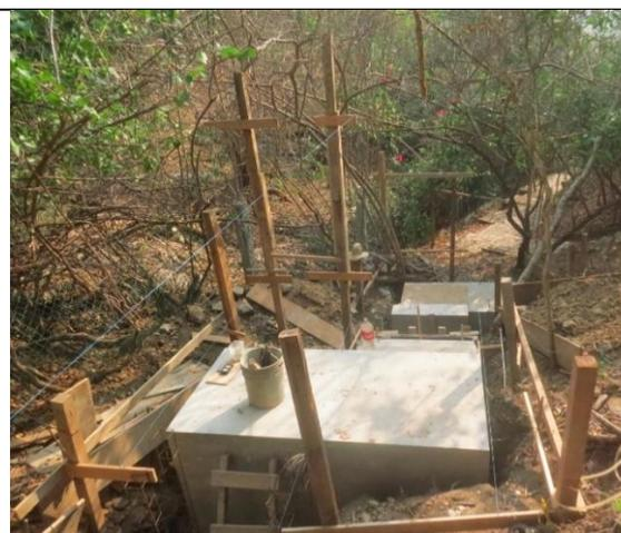
**Figura 45.** Bases terminadas para las escaleras que llegaran hasta el andador comunal que se observa al fondo de la imagen.
