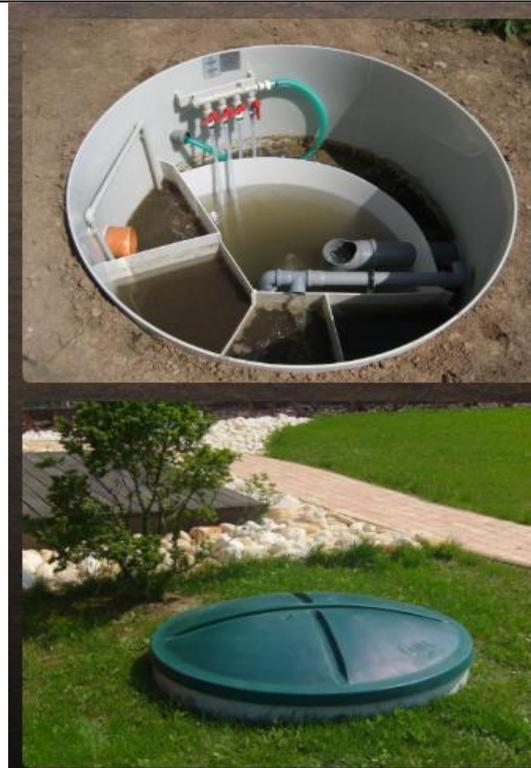
**Figura 53.** Fotos ilustrativas de la PTAR funcionando.
