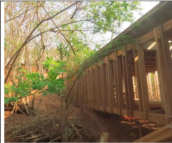
**Figura 35.** Vista lateral de la estructura del Muelle formada por vigas de madera.
