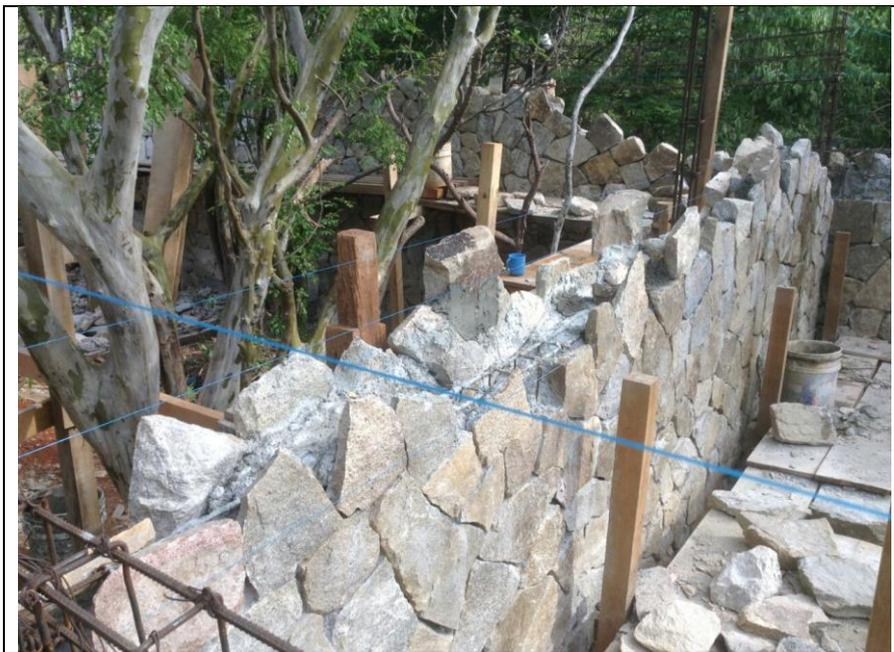
Forrado de las paredes con piedra blanca después de colado de concreto
