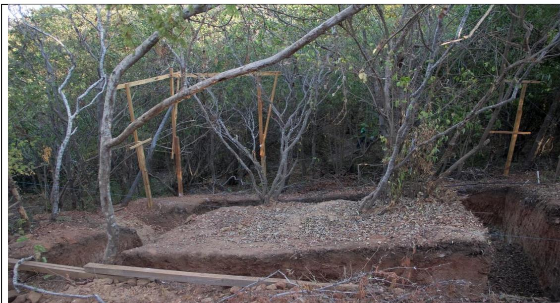
**Figura 48.** Trazado para la cimentación de las construcciones.
