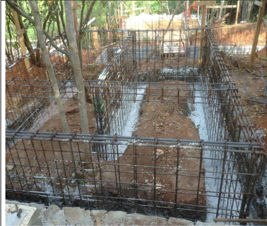
Armado con varilla de las paredes previo la colado de concreto
