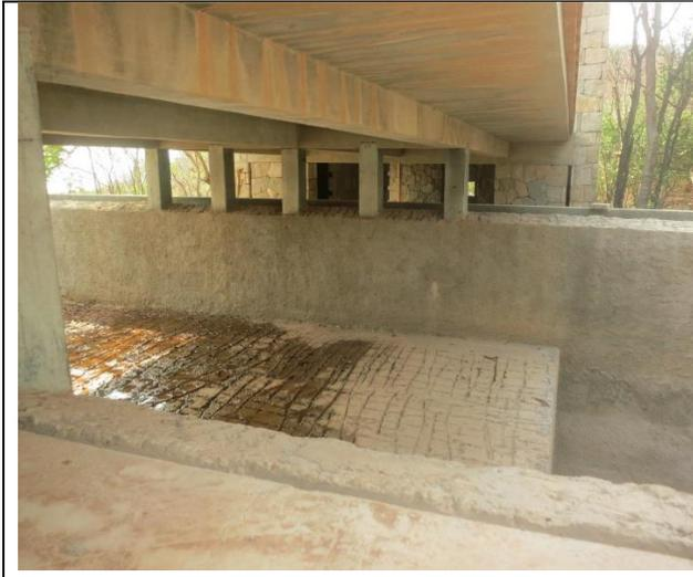
**Figura 31.** Bases de concreto armado que sostienen el asoleadero, abajo se observa la alberca y la fosa de clavados.
