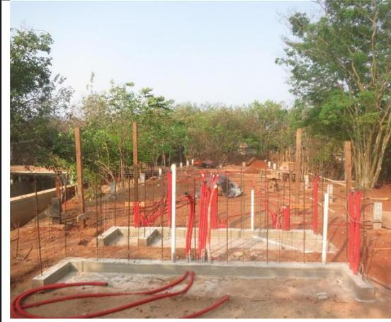
**Figura 27.** Vista general de la construcción de la palapa, se observan los tubos para la cablearía eléctrica.
