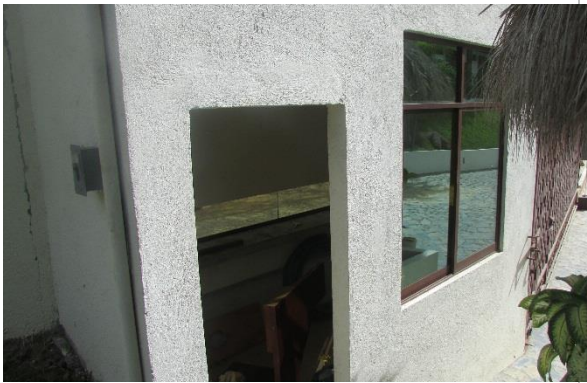
Caseta de Vigilancia
