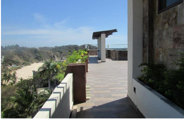
Jardineras en el techo del edificio
