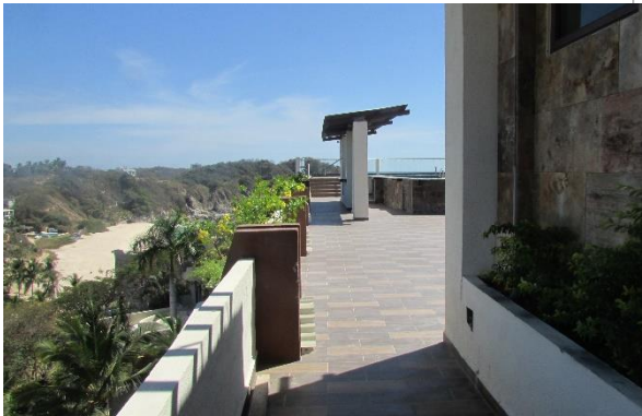
Jardineras en el techo del edificio
