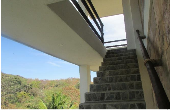
Escaleras que conducen a la azotea del edificio
