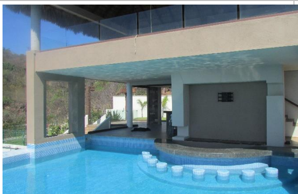
Alberca con barra y losa de concreto armado, una parte corresponde al predio
