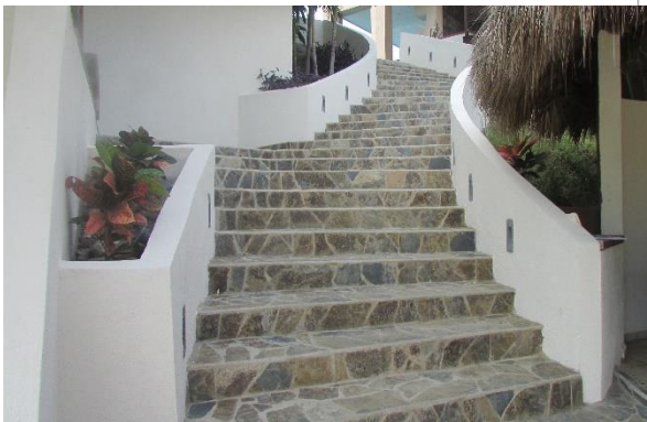
Escaleras de acceso al primer nivel del edificio
