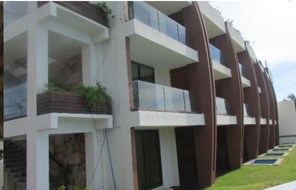
Edificio principal vista posterior se observan las terrazas, una parte se ubica en ZOFEMAT
