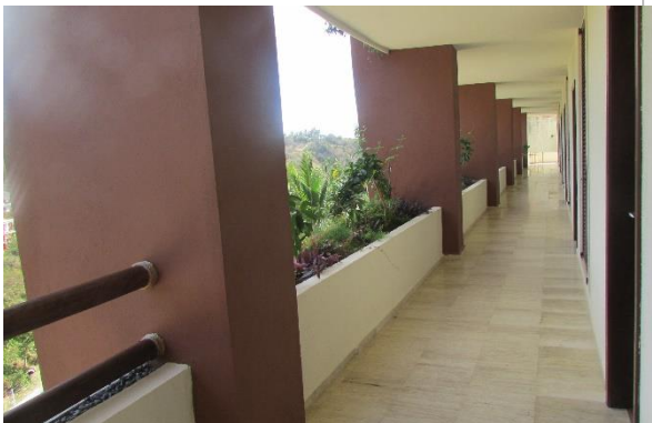
Pasillo frontal del edificio niveles 1, 2 y 3
