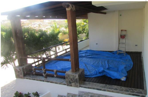
Entarimado de madera en planta baja del edificio
