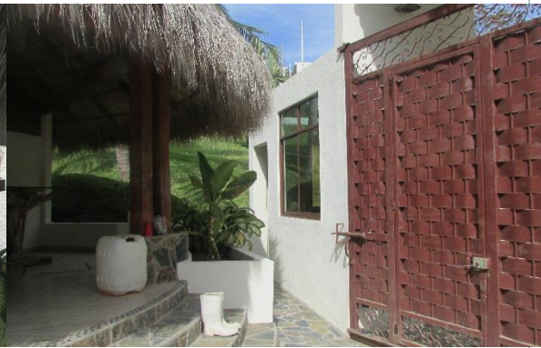
Caseta de Vigilancia
