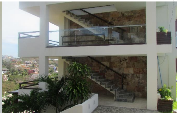
Escaleras acceso niveles 2 y 3
