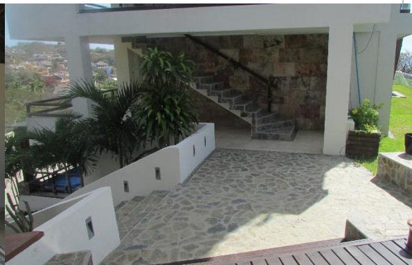
Pasillo de acceso al primer nivel del edificio
