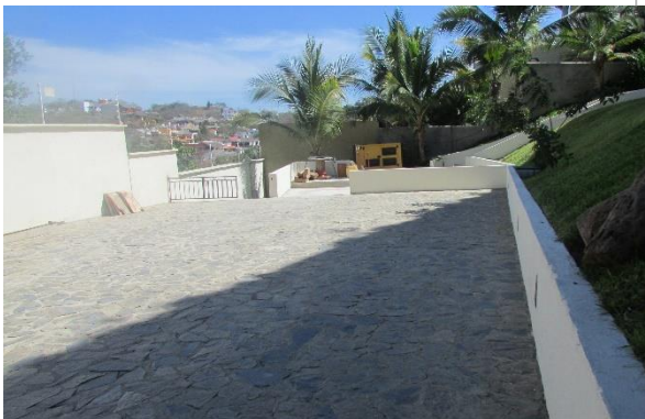
Área de estacionamiento y área verde
