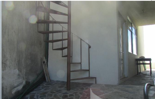
Cuarto de servicio del hotel, una parte se ubica en ZOFEMAT
