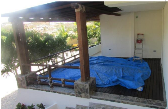
Entarimado de madera en planta baja del edificio
