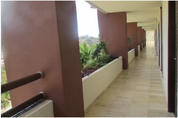
Pasillo frontal del edificio niveles 1, 2 y 3
