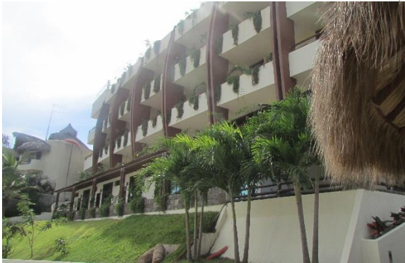
Edificio principal vista frontal se observan los pasillos
