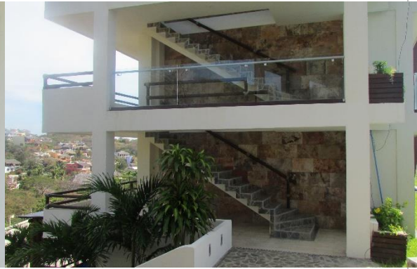
Escaleras acceso niveles 2 y 3
