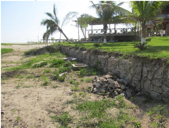
Gaviones para la estabilización del terreno en la Casa Construida
