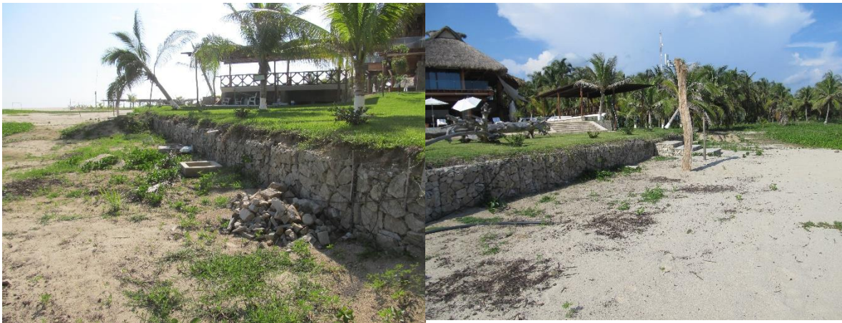
Vista de los gaviones para estabilizar el terreno
