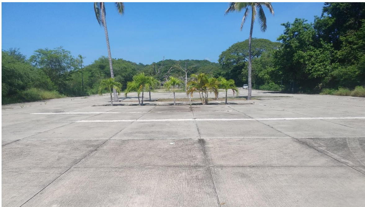
Andador 2 con pavimento de concreto hidráulico (a un costado del predio)
