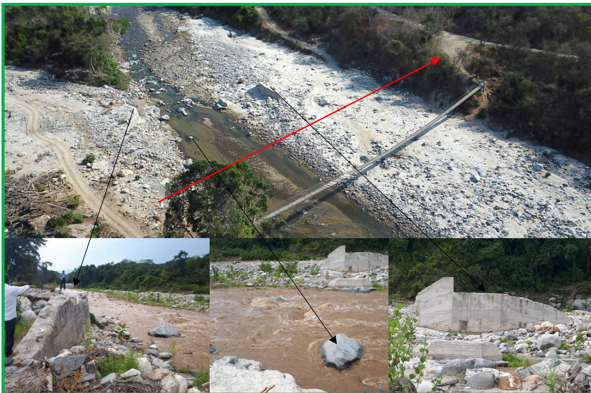
Foto II. 1. Trayectoria del puente.
