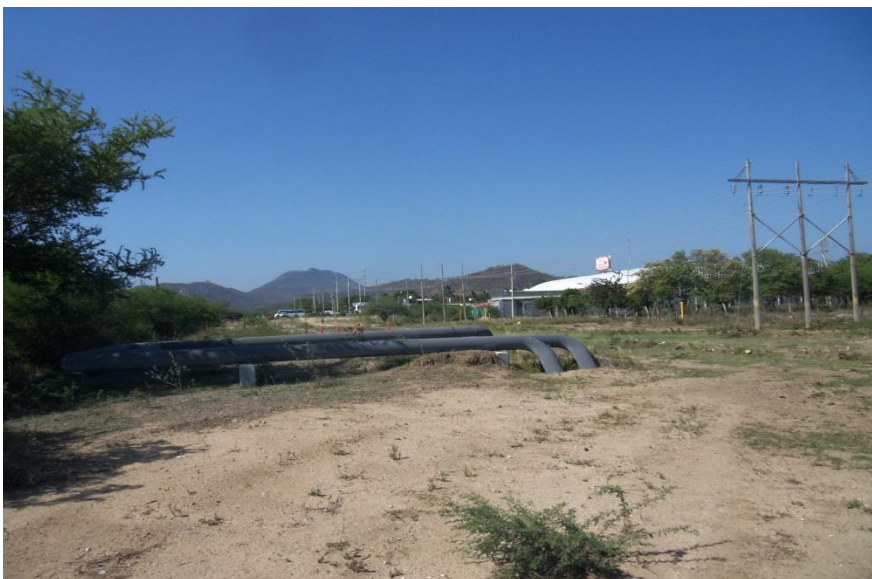
Figura IV.2.3.e.- Calidad paisajística del entorno inmediato. Las colindancias inmediatas se encuentran totalmente urbanizadas.
