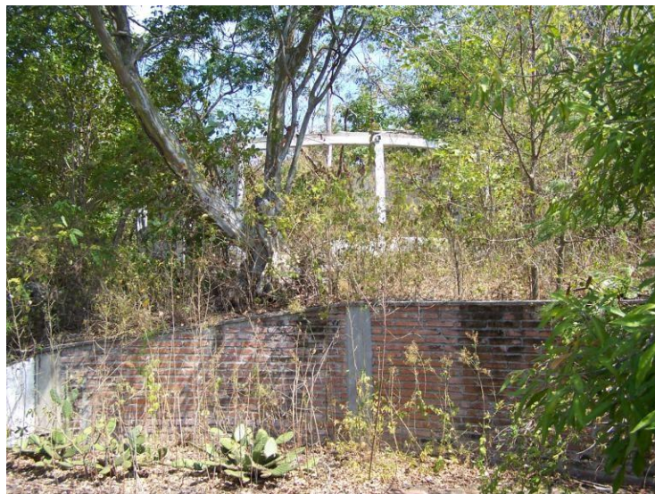
Construcciones ubicadas en la porción sur del predio.
