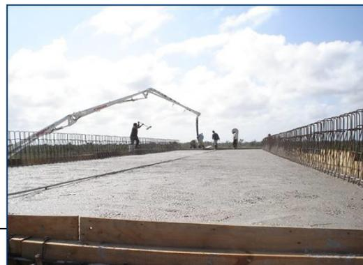
**Imagen II.9** Proceso de habilitado y colado de la losa en obras similares.
