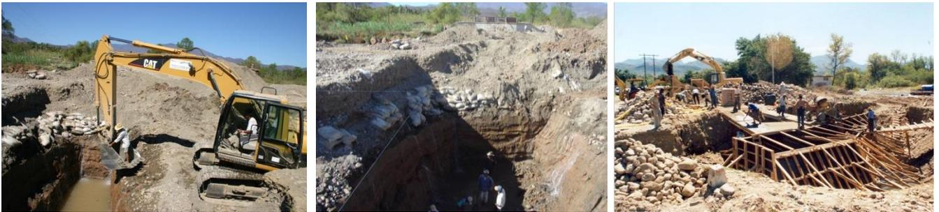
**Imagen II.6** Vista de los procesos de excavación, colocación de plantilla de concreto y cimbrado en obras similares.
