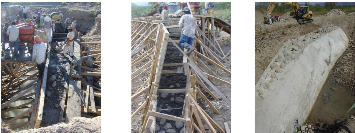
**Imagen II.7** Vista de los procesos de construcción de los estribos de concreto en obras similares.
