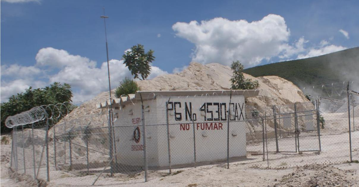
Ilustración II-13. Polvorín instalado dentro del área de trituración misma que se encuentra autorizado por parte de la SEDENA cumpliendo con la normatividad aplicable
