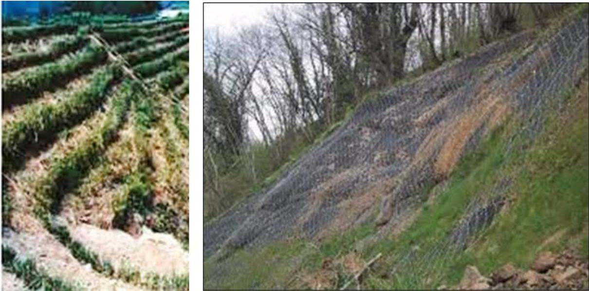
Ilustración II-13. Ejemplo de revegetación con pastos en una primera etapa y de suavizar taludes
