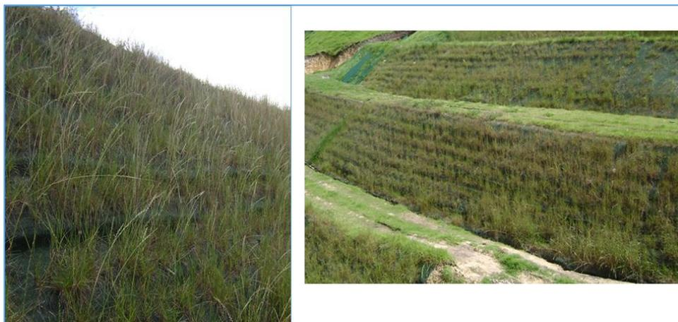
Ilustración VI-2 Ejemplo de estabilización de taludes mediante la colocación de biomanta donde se regenera el pasto
