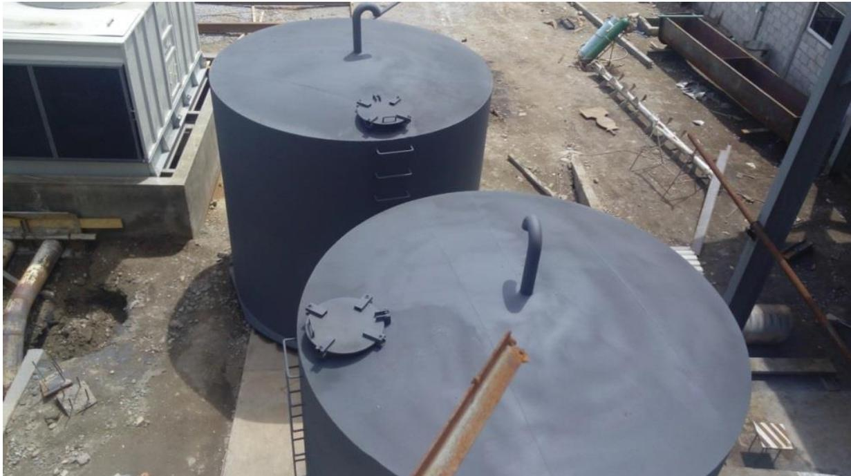
Imagen 22. Tanques de condensados
