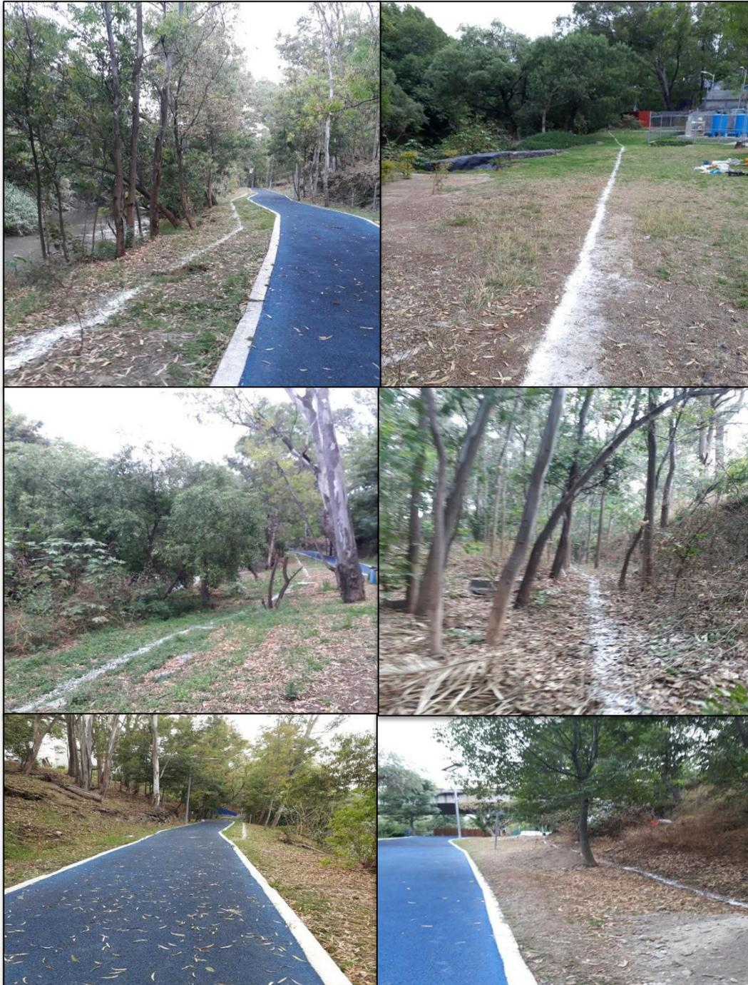
**Imagen 06.** Trayectoria de la línea, en color blanco el trazo de la tubería a instalar.
