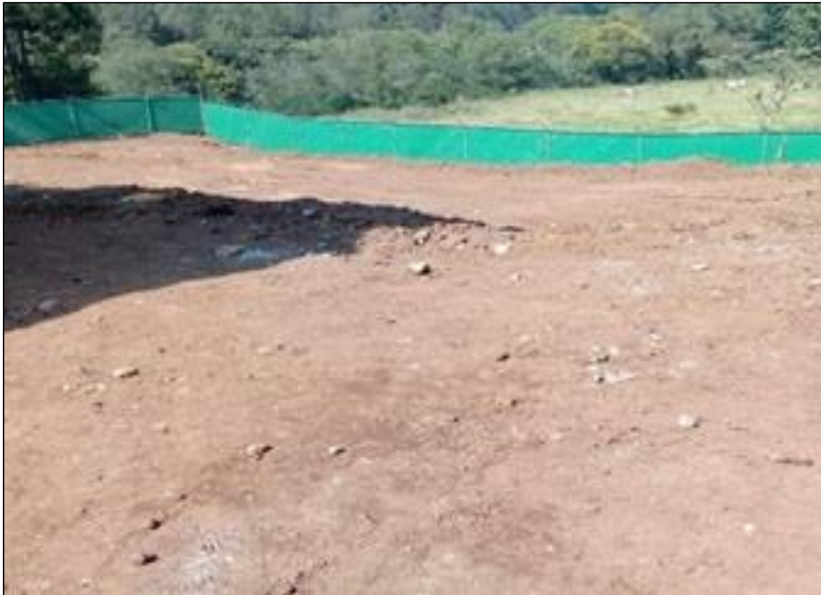
Imagen 14 Excavación para la cimentación de la Planta de Tratamiento.
