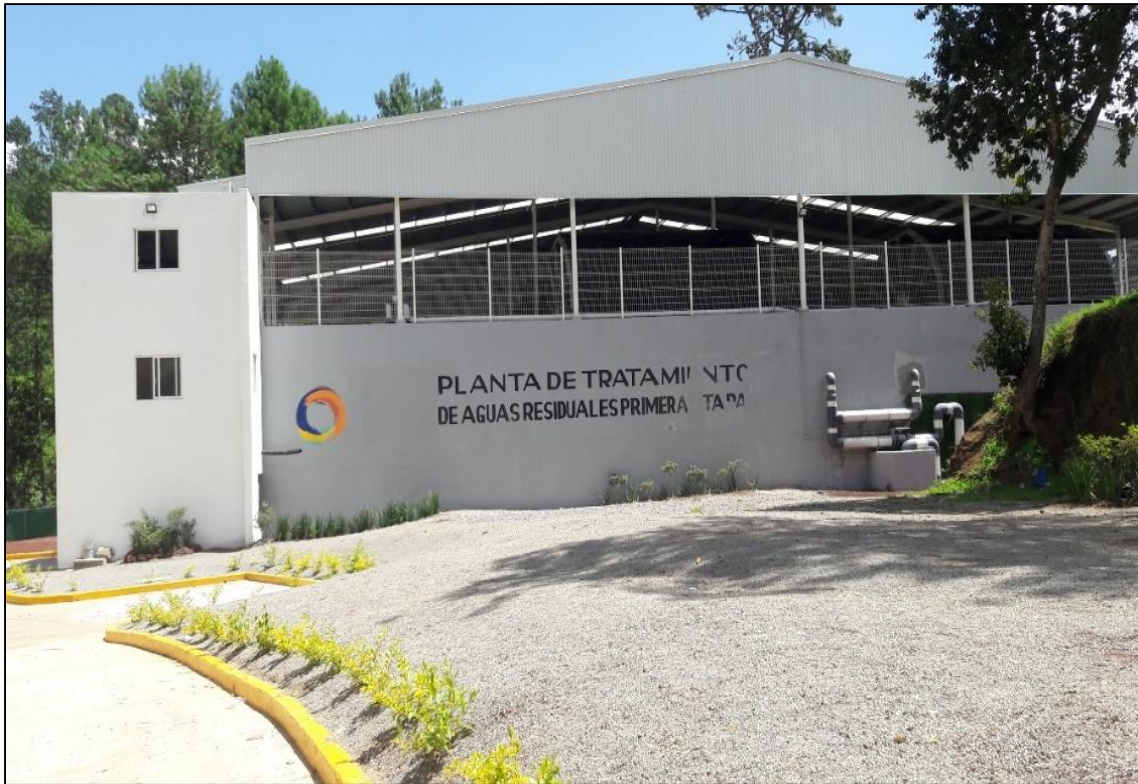
Imagen 15 Vista de la Planta de Tratamiento de Aguas Residuales.
