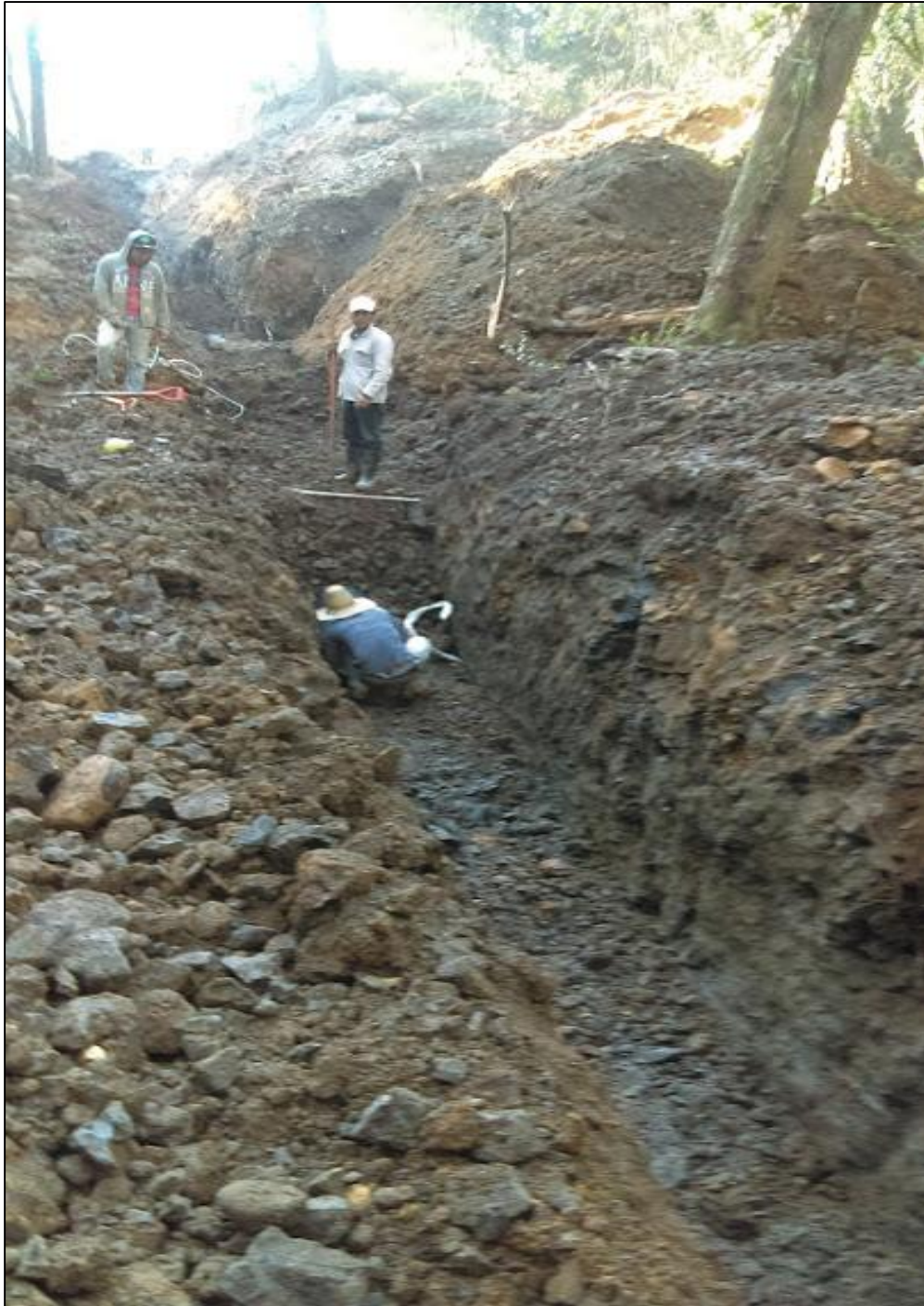
Imagen 16 Vista de la apertura de zanjas para la introducción de la tubería.
