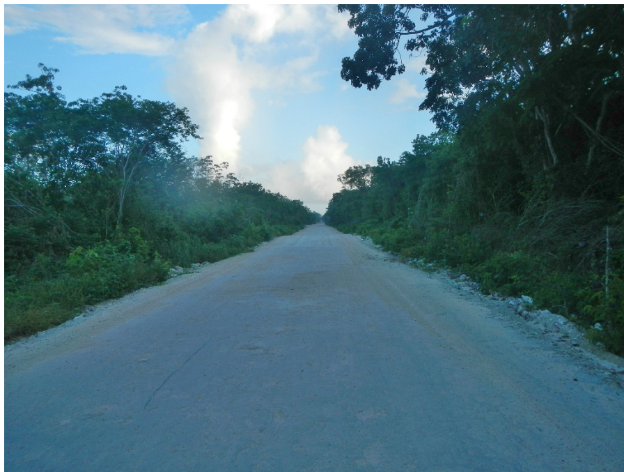
Figura VIII.4. Camino rústico que se encuentra a aproximadamente 10 metros del límite poniente del predio.
