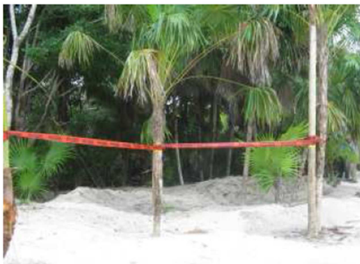
Figura 56. Imagen de la delimitación de una obra con cinta de seguridad.
