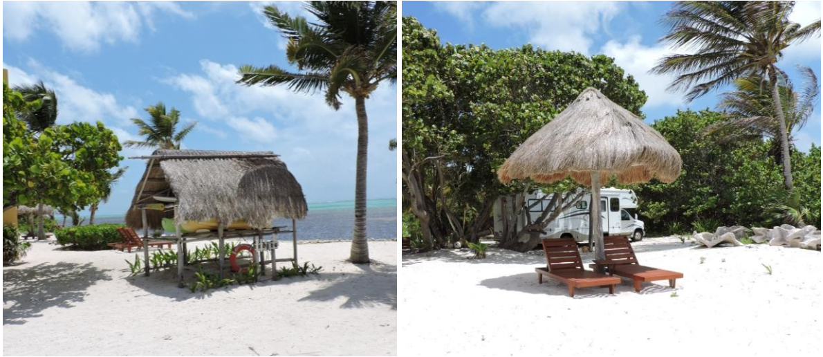
Fig. 6.- Vista de obras construida en la ZOFEMAT. Consistentes en palapa y sombrilla de madera y palma de huano.
