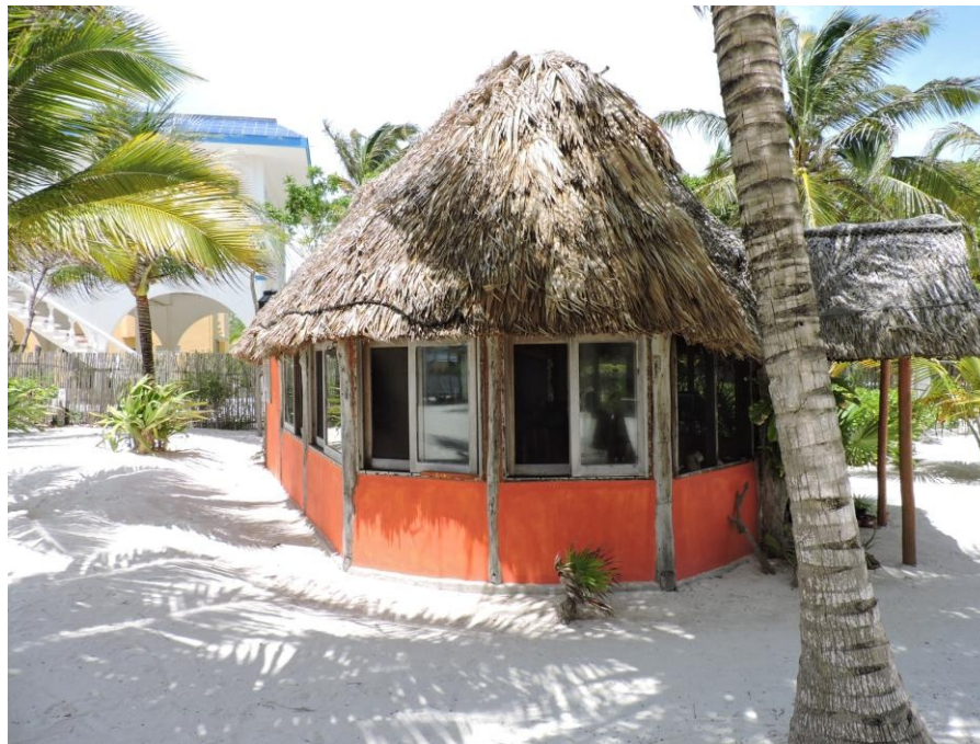
Fig. 5.- Figura que muestra el sitio donde se construirá el restaurante, sobre la palapa existente que hoy funciona como comedor (comedor improvisado) y oficina administrativa.
