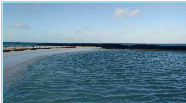
Figura II_ 21. Ejemplo de formación de tómbolos al Sur del proyecto, generados por la colocación de rompeolas paralelos autorizados.
