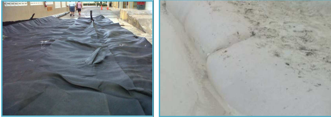
Figura II_ 17. Saco de geotextil vacío y ejemplo de elemento de geotextil temporal de apoyo.
