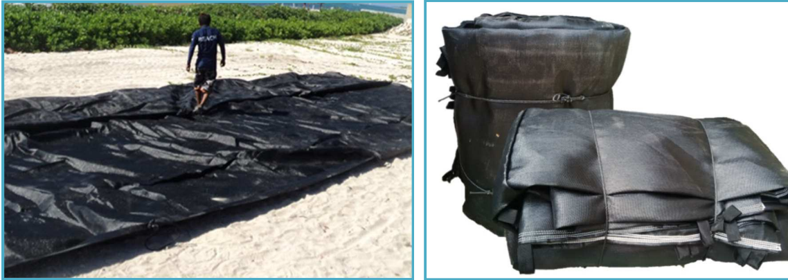
Figura II_ 23. Tubos de geotextil para el desplante de rompeolas.
