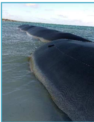
Figura II_ 21. Ejemplo de formación de tómbolos al Sur del proyecto, generados por la colocación de rompeolas paralelos autorizados.
