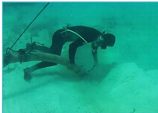
Figura II_ 37. Colocación de tuberías y mangueras para el transporte de arena.
