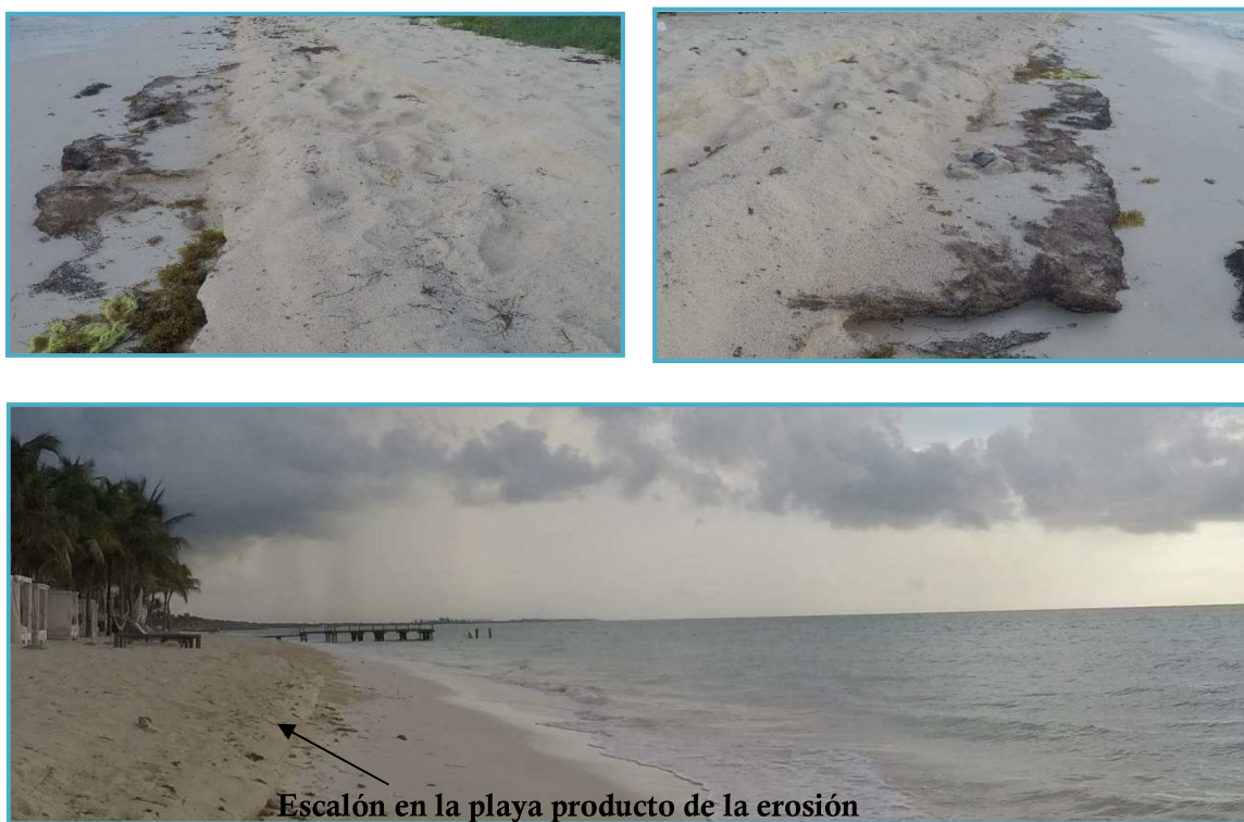
Figura VII_2. Estado actual del área del proyecto.
