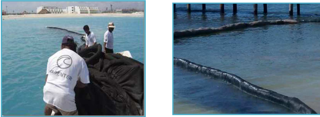
Figura II_ 33. Colocación y funcionamiento de malla antidispersión, en proyectos similares.
