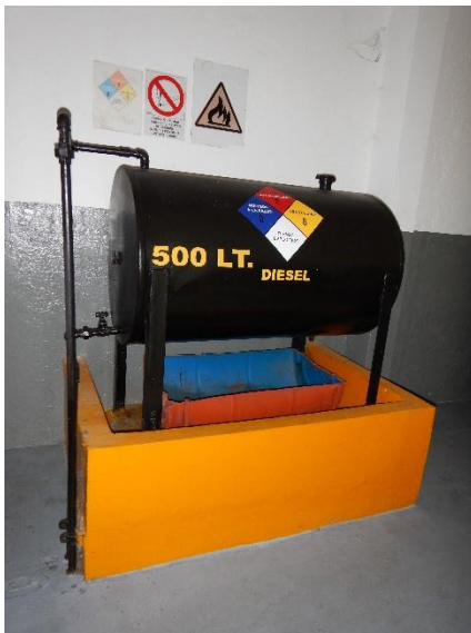
Figura 31. Se muestra el tanque de diésel. El almacenamiento cumple con las normas de seguridad aplicables en la materia.
