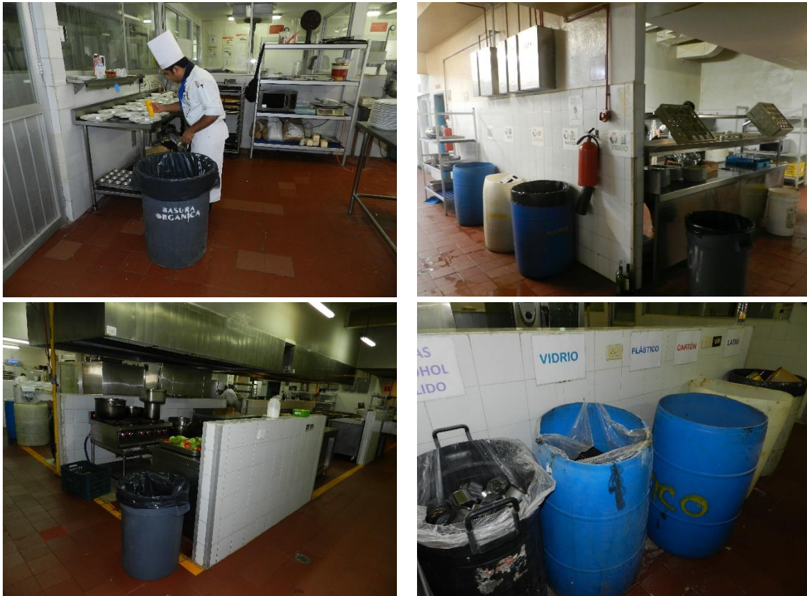
Figura 36. Al interior de las áreas de preparación de alimentos y en el área de lavado se cuenta con contenedores para el acopio residuos. El personal de limpieza recupera dichos residuos y los traslada a las áreas de almacenamiento temporal.
