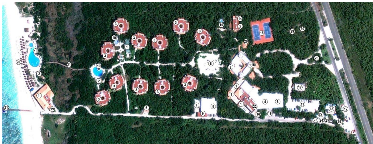
Figura 6. Planta de conjunto del hotel Occidental Cozumel. 1. Restaurantes con servicio de alimentos y bebidas; 2. Bares; 3. Habitaciones (edificios); 4. Lavandería, almacén general; 5. Áreas administrativas y cuartos de máquinas (planta de ósmosis, sistema contra incendio, calentadores); 6. Almacenes, oficinas; 7.
