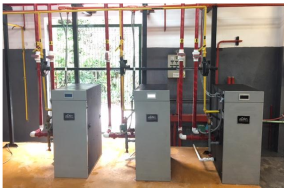
Figura 41. Se aprecian los calentadores APX 425 para gas LP.
