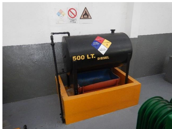
Figura 31. Se muestra el tanque de diésel. El almacenamiento cumple con las normas de seguridad aplicables en la materia.
