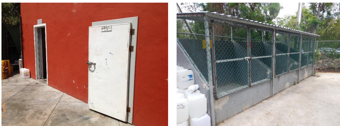
Figura 23. Para el acopio y almacenamiento temporal de residuos sólidos la empresa cuenta con cámara húmeda refrigerada, cámara seca (fotografía de la izquierda) y área de almacenamiento de residuos sólidos reciclables (derecha), subdividida para el acopio de plásticos, metales, vidrio y cartón. En esta área también se acopian los envases retornables de sustancias químicas.
