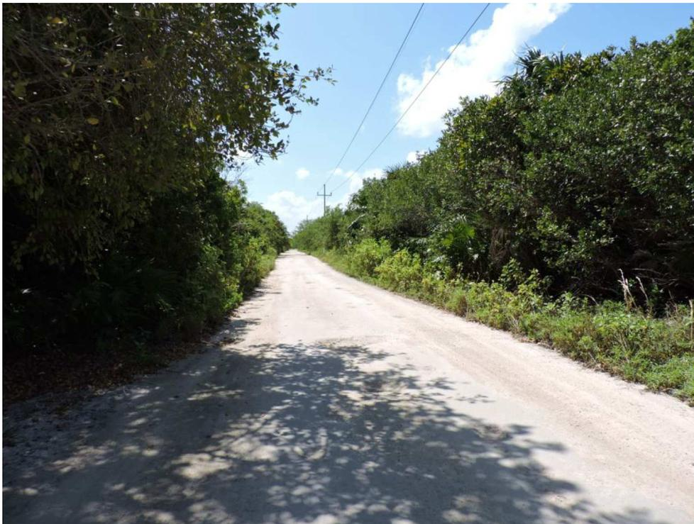
**Fig. 8.-** Vistas del camino costero que atraviesa por el área de interés. se observa un camino rústico, es decir sin pavimento de unos 5.00 metros de ancho utilizado como paso de servidumbre para tener acceso a los predios distribuidos en la franja costera.
