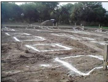
Una vez realizado el trazo, se marcará con cal el lugar exacto donde se realizara la excavación para los doce pilotes, para la cisterna de almacenamiento de agua potable y para la cisterna de tratamiento de aguas residuales.
