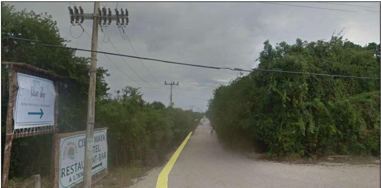
Imagen de la entrada Sur de la zona costera donde se construirá el proyecto, como se observa es de terracería de sascab compactado. Se observa también la línea de energía eléctrica que abastece de este recurso a toda la zona.
