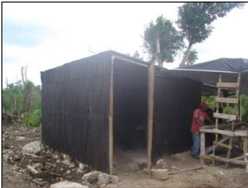
Se construirá una bodega provisional de lámina de cartón empetrolado para el resguardo de herramientas y materiales que se utilizarán en las etapas de preparación del sitio y construcción. (La imagen corresponde a un ejemplo de bodega).
