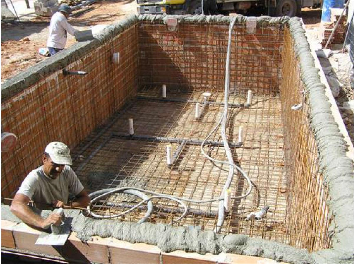
La base de hormigón debe tener unos 40 cm de espesor, para tener seguridad en que está correctamente ejecutada. Puede tener una armadura en el centro, o mejor aún si se coloca doble armadura: una cerca de la base y la otra cerca de la zona superior. Esta armadura puede estar constituida por una rejilla de hierros de diámetro 12 mm cada 20 cm.
