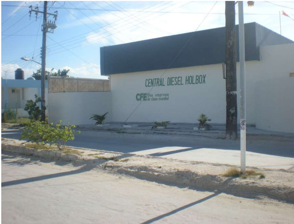
Imagen 58.- Planta generadora de energía eléctrica CFE Isla Holbox.
