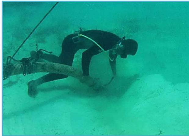
**Figura II\_ 23. Colocación de tuberías y mangueras para el transporte de arena.**
