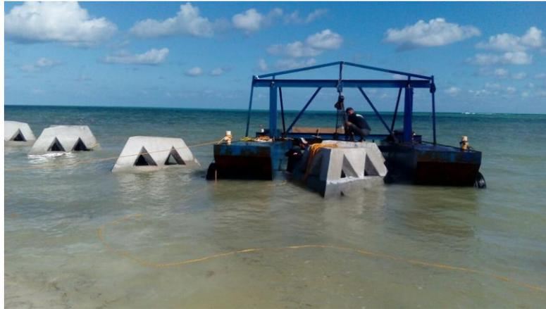
**Figura 6. Ejemplo de la barcaza que será utilizada para la colocación de los AMA® en el sitio de pretendida ubicación del proyecto.**
