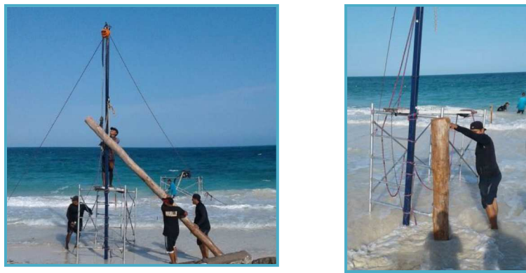
Figura II_ 25. Proceso de colocación de los pilotes, usando chorro de agua a presión.
