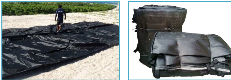
Figura II_ 31. Ejemplo de tubos de geotextil para la habilitación de la sección de refuerzo de los asoleaderos.
