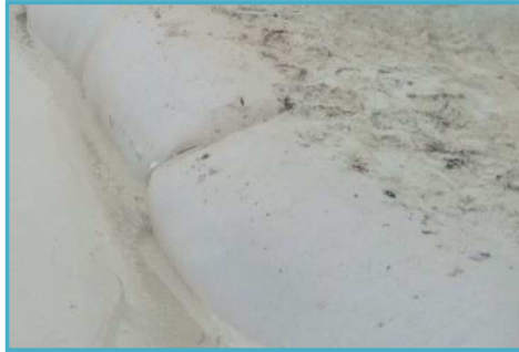
Figura II_ 23. Ejemplo de elemento de geotextil temporal de apoyo.
