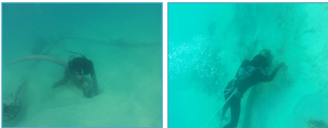
Figura II_ 37. Colocación de tuberías y mangueras para el transporte de arena.
