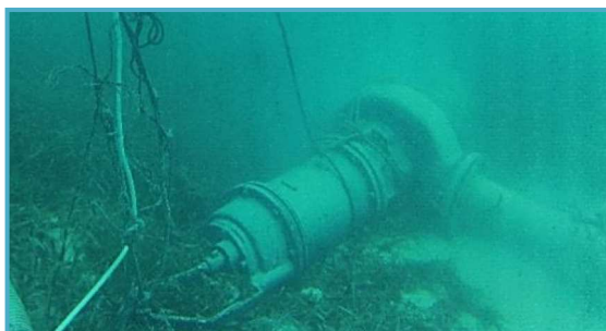
Figura II_ 33. Bomba sumergible utilizada en proyectos similares
