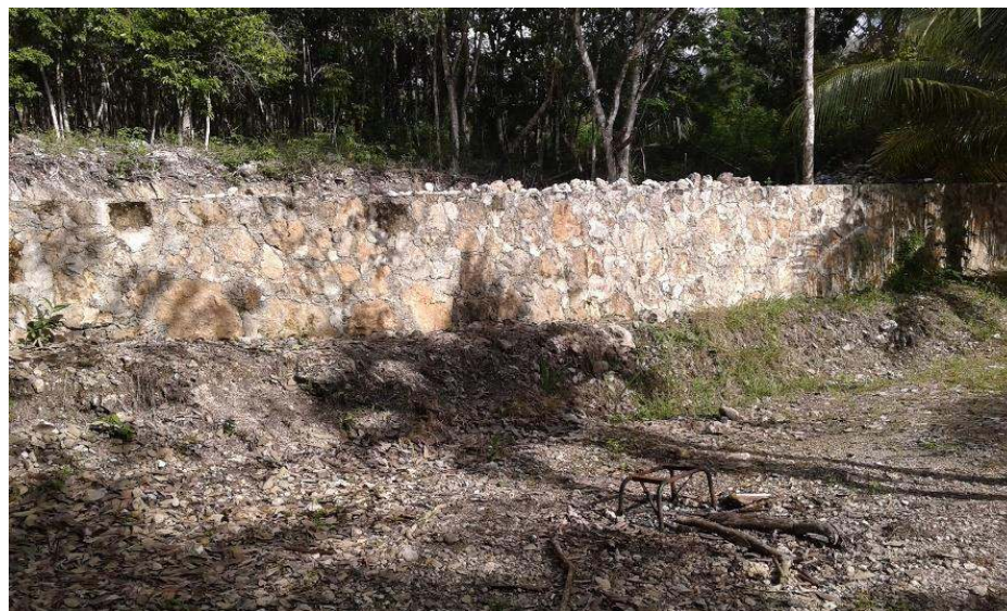
Imagen II.22. Muro de contención.
