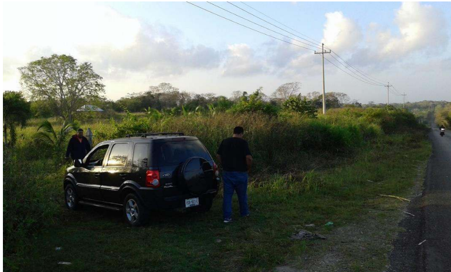
Imagen II.7. Línea de conducción Eléctrica.
