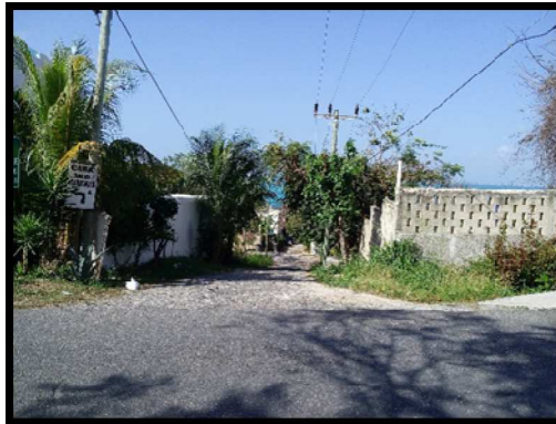
Figura 54. Barda perimetral del predio
