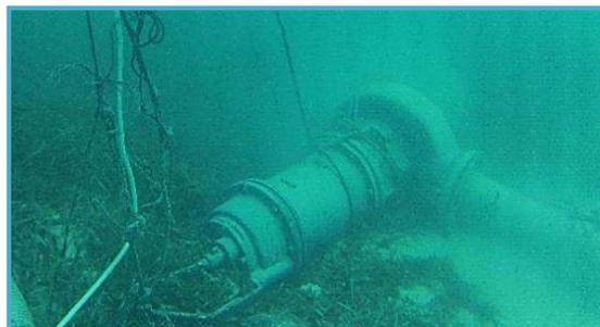
Figura II\_ 32. Bomba sumergible utilizada en proyectos similares
