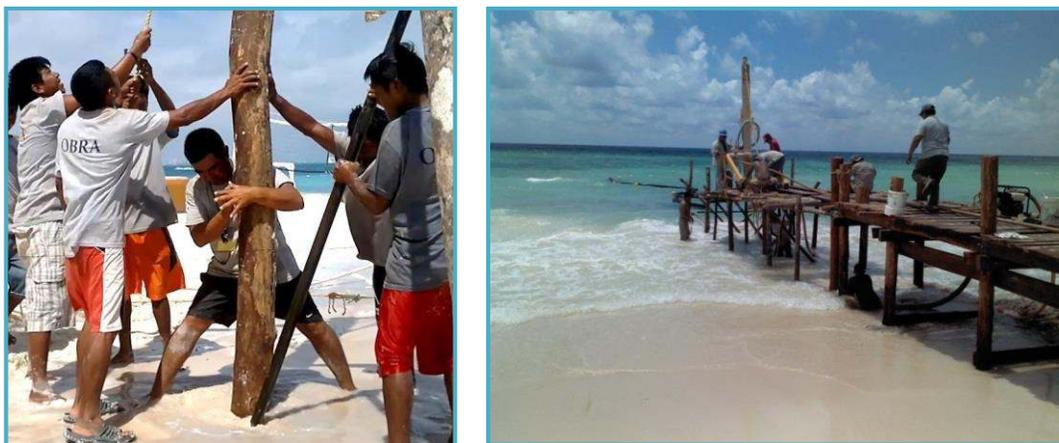
**Figura II\_ 24. Proceso de colocación de los pilotes de soporte del muelle usando chorro de agua a presión en sustrato arenoso y piloteadora en fondo rocoso.**
