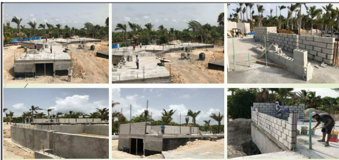
Figura 30.- Alzado de los muros internos que dividen las áreas en la casa/habitación
