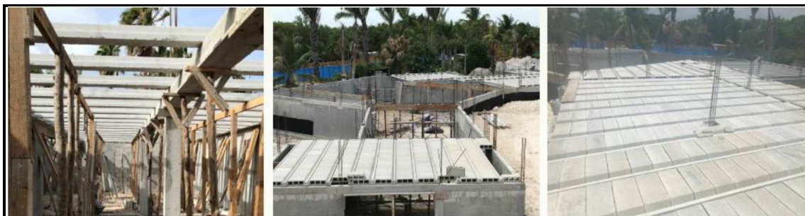
Figura 26.- Cimbrado de la losa y topes de contención de concreto
