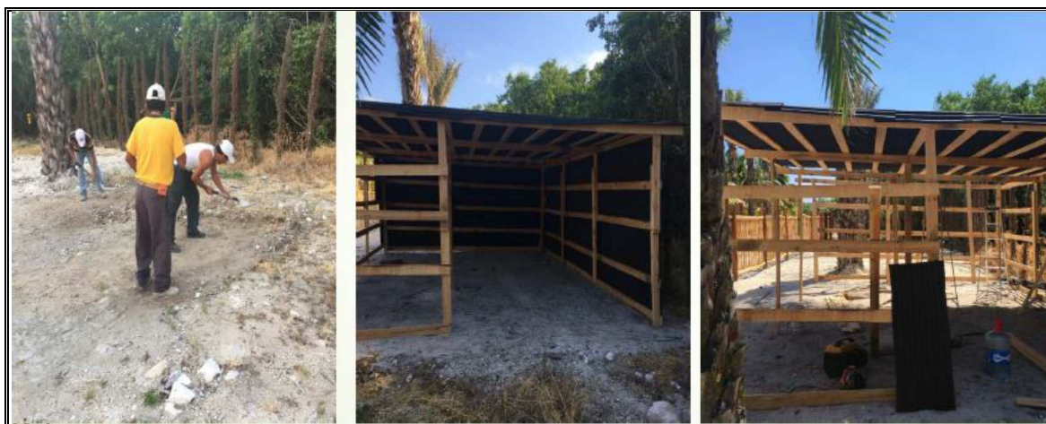
Figura 15.- Se observan los trabajos de nivelación del sitio y relleno con material de sascab en una superficie de 1414 m 2 donde se colocó la bodega y se realizó la siembra de 126 ciprés y 14 palmas corozo
