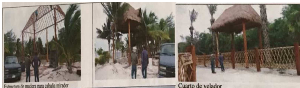
Figura 35.- Obras realizadas y sancionadas de las cabañas con distintos porcentajes de avance de obra
