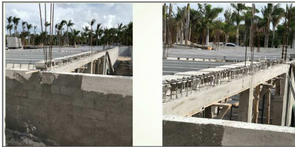
Figura 25.- Armado de las trabes y colocación de la losa de cimentación
