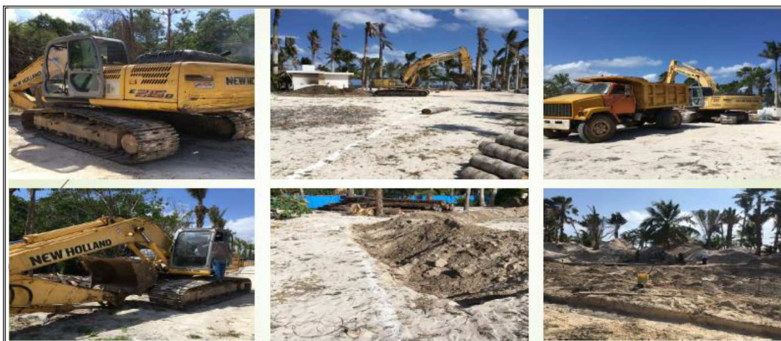
Figura 18.- Obras de desplante de la casa consistente en la excavación del sótano y piscina
