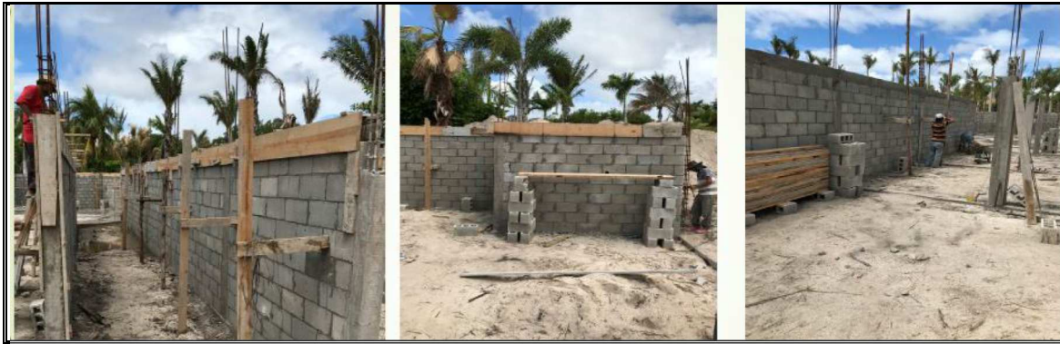
Figura 24.-Cimbra y colado de la cadena de nivelación de estructura armada con varilla y alambrión
