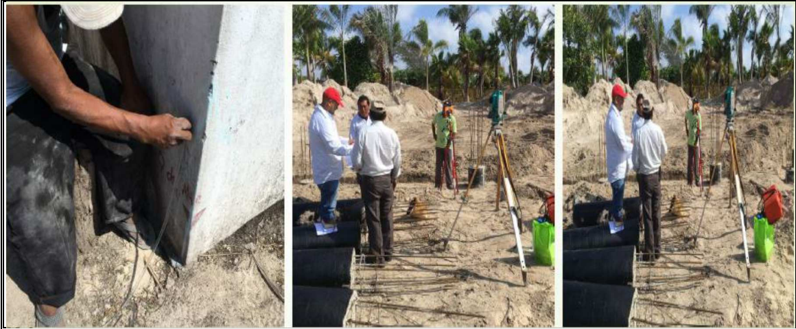
Figura 20.- Toma de niveles y posicionamiento de los pilotes estructurales del proyecto
