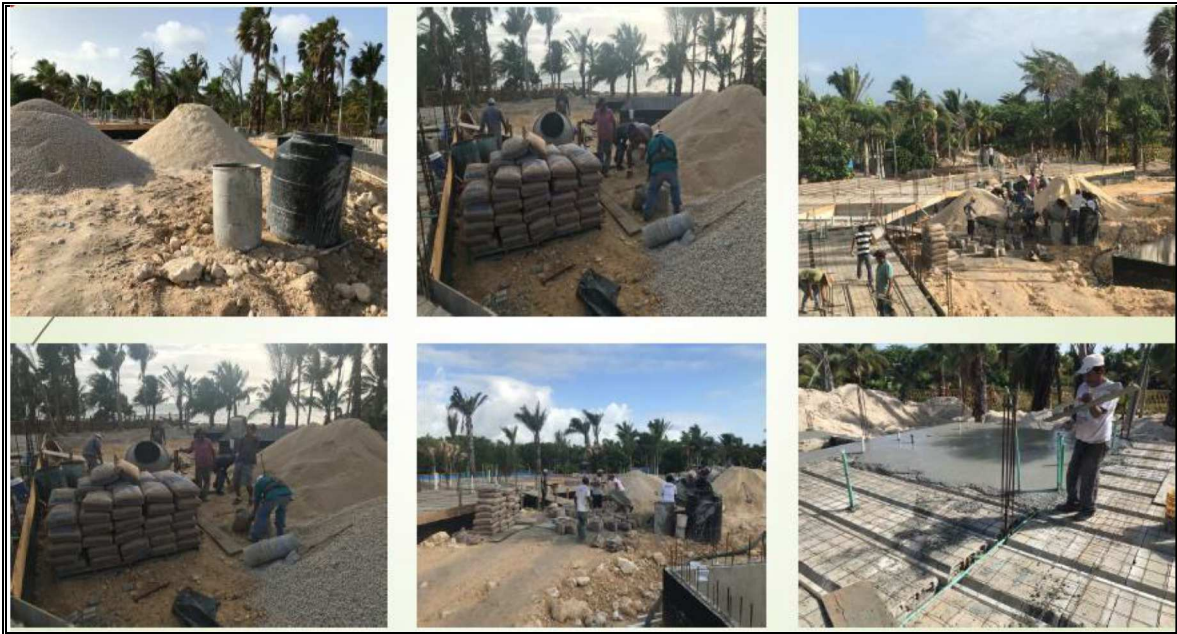
Figura 28.- Proceso de colado de la losa de cimentación; el cemento, agua, polvo y grava se colocaron en un solo sitio; los residuos de las bolsas de cemento se hicieron en pacas y se dispusieron en contenedores para su disposición final
