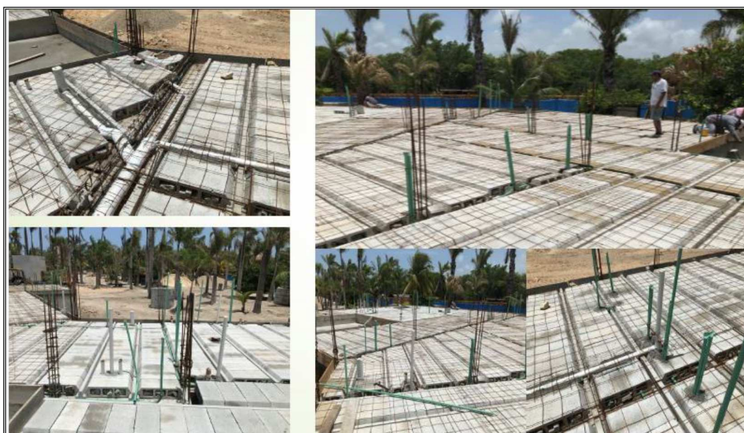
Figura 27.- Colocación de las instalaciones eléctricas, hidráulicas y sanitarias previo al vaciado del concreto, así como se verifica que este en buen estado
