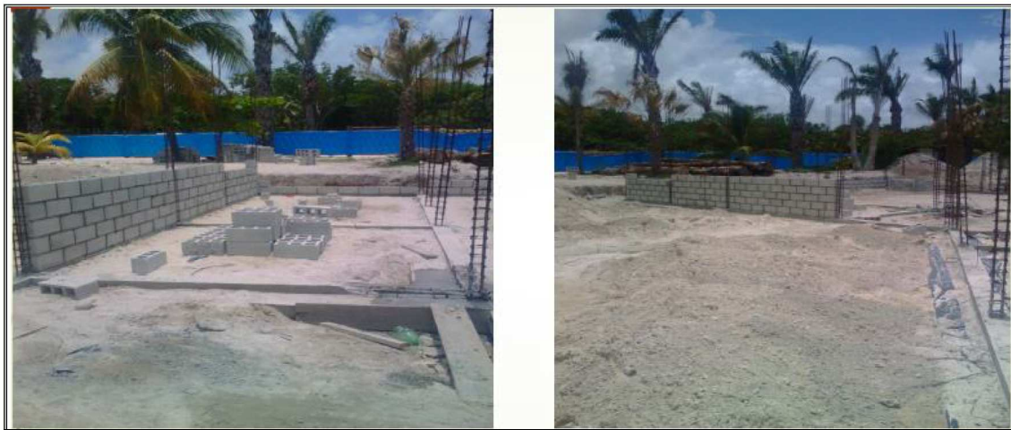
Figura 22.- Levantado de muros de block de la región sobre las cadenas de desplante
