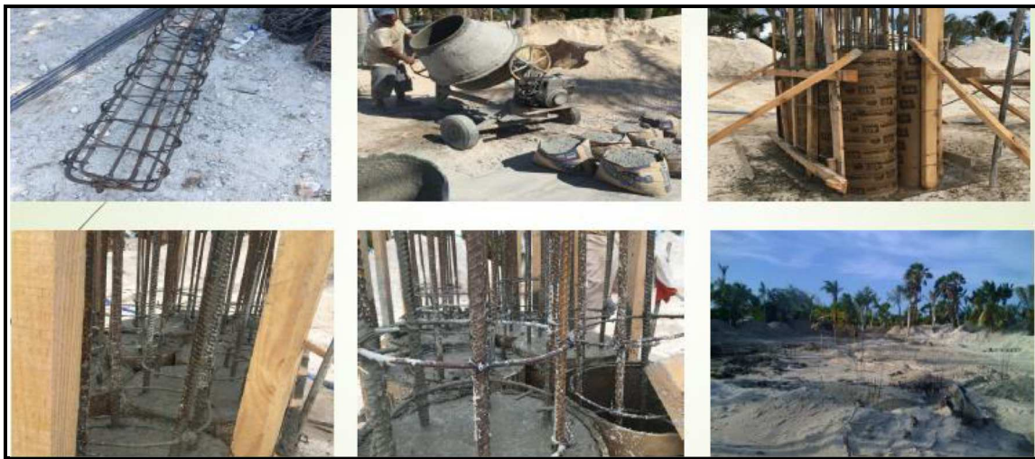
Figura 19.- Armado y colado de los pilotes estructurales para las obras de cimentación del sótano
