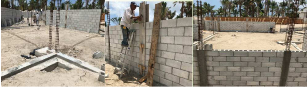
Figura 23.- Cimbra y colado de los castillos estructurales cuya función es dar soporte a los muros de block
