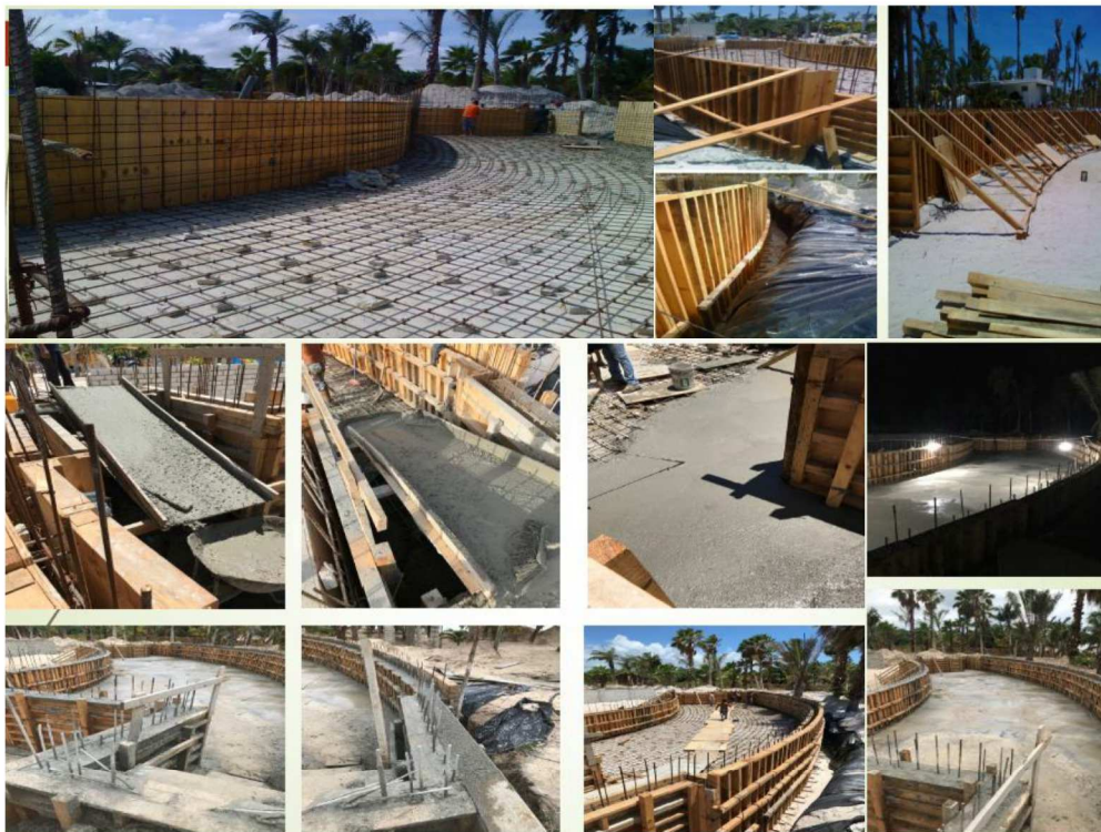
Figura 32.-Proceso de cimbra y colado de los muros estructurales de la piscina
