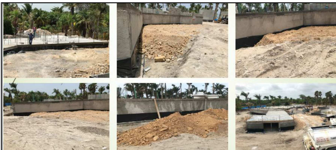
Figura 29.- Colocación del material de relleno producto de banco entre el muro de la cimentación de la casa/habitación y las obras de piscina para la nivelación del terreno
