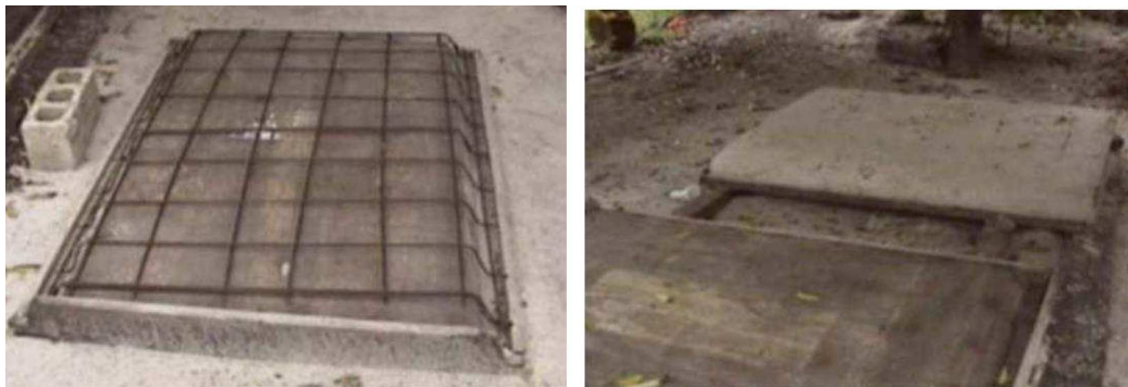
Fig 5. Ejemplo de unidades de arrecifes artificiales construidas.
