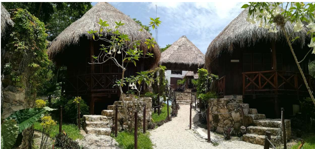
Foto 15.- Vista de los andadores y escaleras de acceso a las cabañas.
