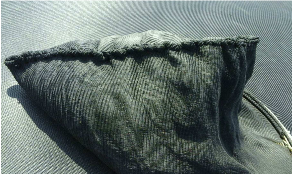
Figura 20. Clausura de puertos de llenado por medio de costura.
