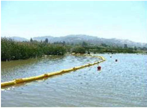
Figura 13. Sistema de malla antiturbidez de finos suspendidos.
