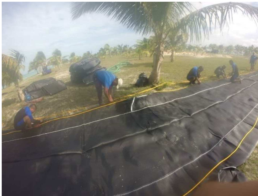
Figura 12. Inspección y habilitación de tubos geotextiles.
