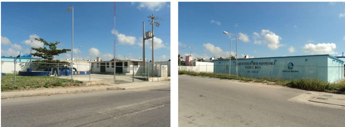
Tanque de regulación de Agua Potable y cárcamo de aguas residuales, denominado Paraíso Maya
