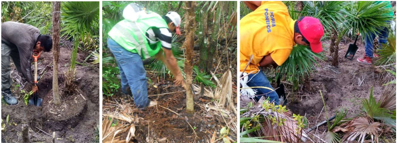
Construcción de la zanja de banqueo
