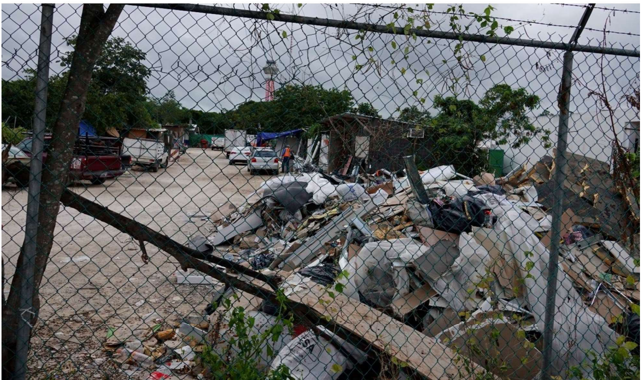
Obras antiguas en el polígono 1, que serán demolidas para dar paso a las obras proyectadas
