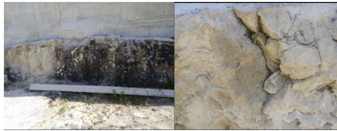
Figura. 28. Izquierda) roca madre expuesta; centro, construcción sobre roca madre; derecha, acercamiento a roca madre.
