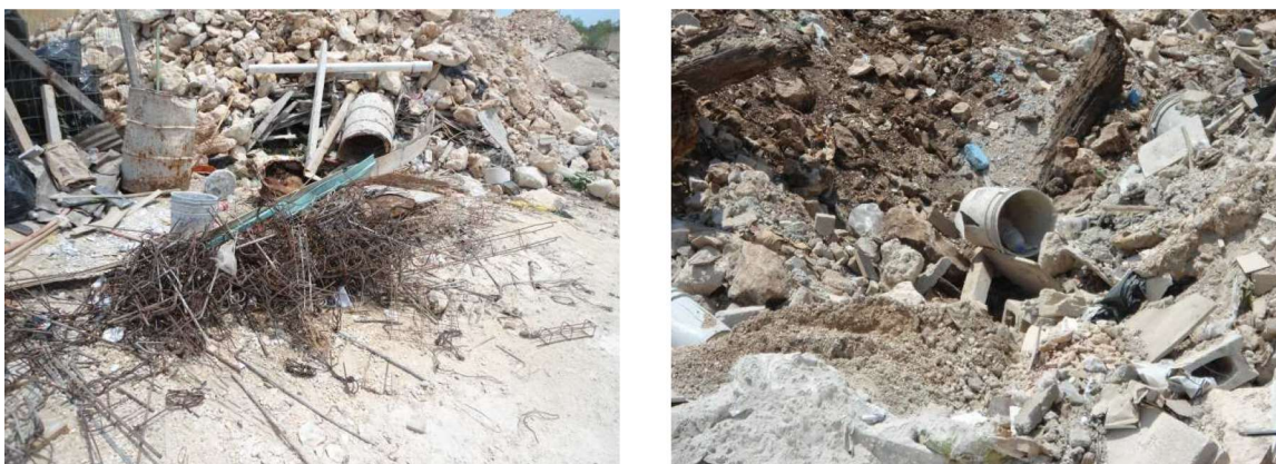
Figura. 15. Ejemplos de los residuos de la remodelación y mantenimiento.
