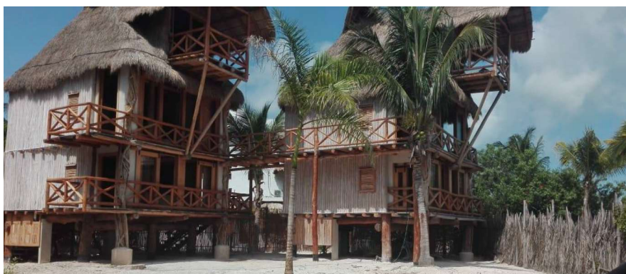
Figura III.3. Obra existente con una altura aproximada de 10.80.
