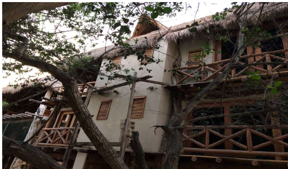
Figura II.5. Construcción de madera y concreto piloteada en tres niveles.
