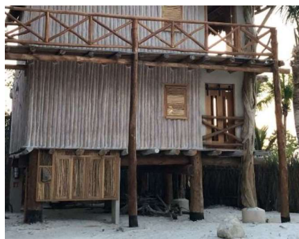
Figura III.5. Obra existente con pilotes construida a una altura de 2.70 m del nivel del terreno.
