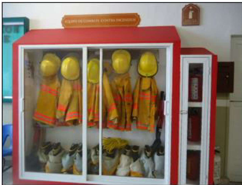
FIGURA 2.12 GABINETE DE COMBATE CONTRA INCENDIOS
