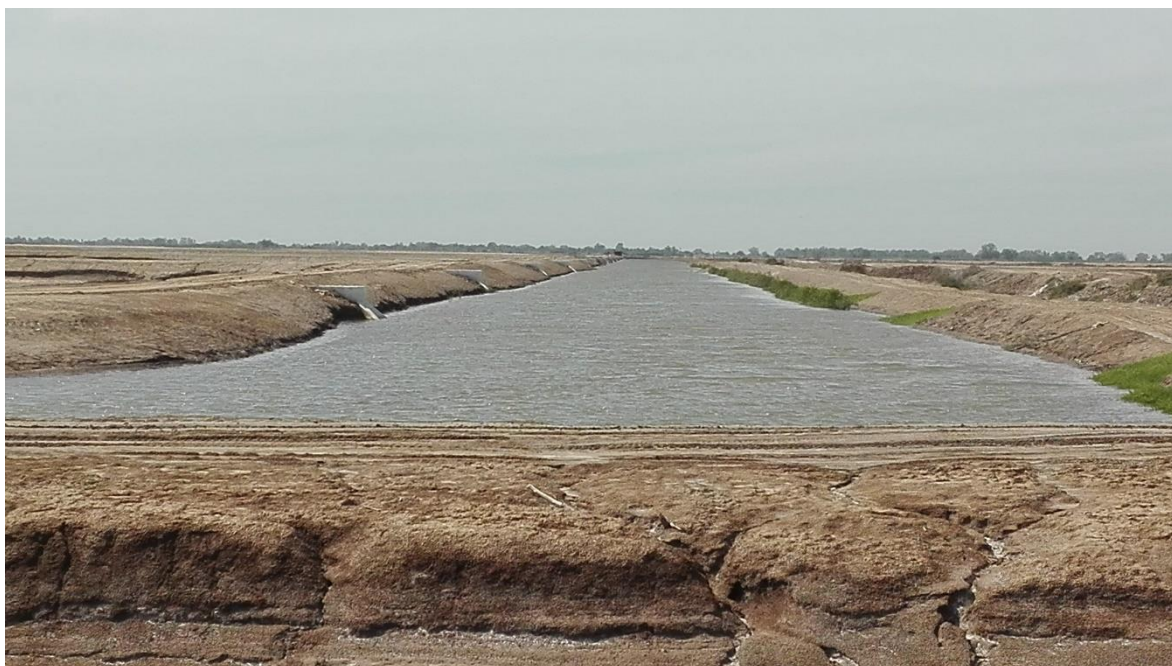
Escenario Actual de la granja, puede apreciarse el Dren de descarga y los estanques en la parte izquierda.
