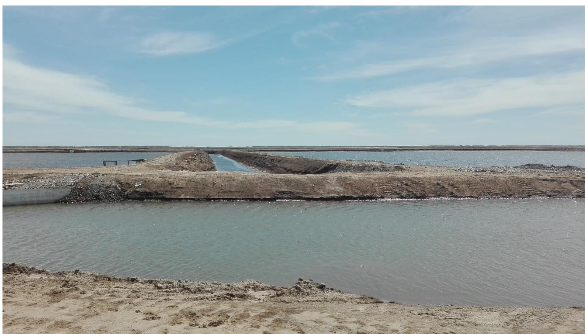
Escenario Actual de la granja, puede apreciarse el Reservorio en primera plana, Dren de descarga al centro y los estanques en los laterales.
