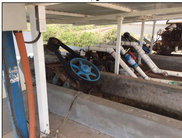
Figura II.3 Se Porción del canal de llamada y cárcamo de bombeo
