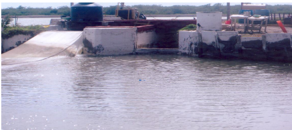
Fotografía 1. Cárcamo o estación de bombeo
