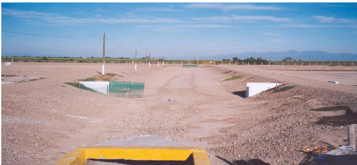
Fotografía 2. Reservorio, compuertas alimentadoras comunes.
