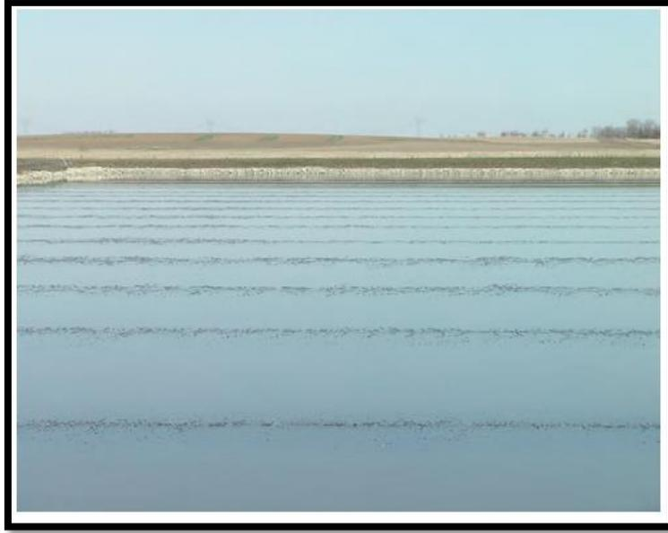
Figura VI.2. Disposición de aireación por del ADS en estructuras acuáticas para el tratamiento de efluentes
